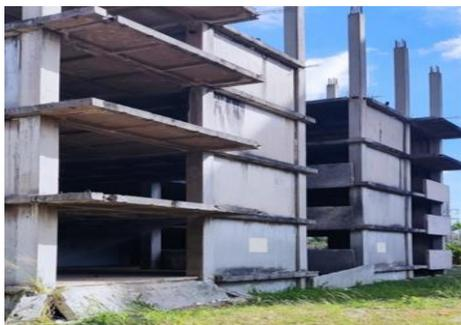
**Figura 2:** Desplome de losa de balcón debido a falla de cono de cables de postesado
