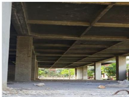
**Figura 3:** Entrepiso 2 con eflorescencias y manchas de humedad. Buena coloración del hormigón en columnas. **Fuente:** Tomada por los autores.
