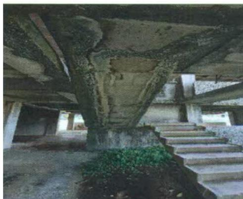
**Figura 5:** Organismos vegetales en el sótano de la edificación. **Fuente:** Tomada por los autores.
