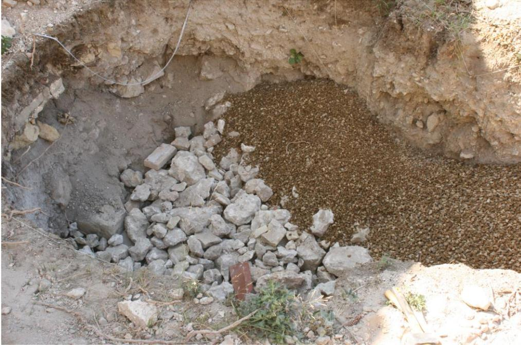
**Fig. 47 -- Corti Beccia (Sanluri): scavo della fossa e realizzazione del vespaio.**
