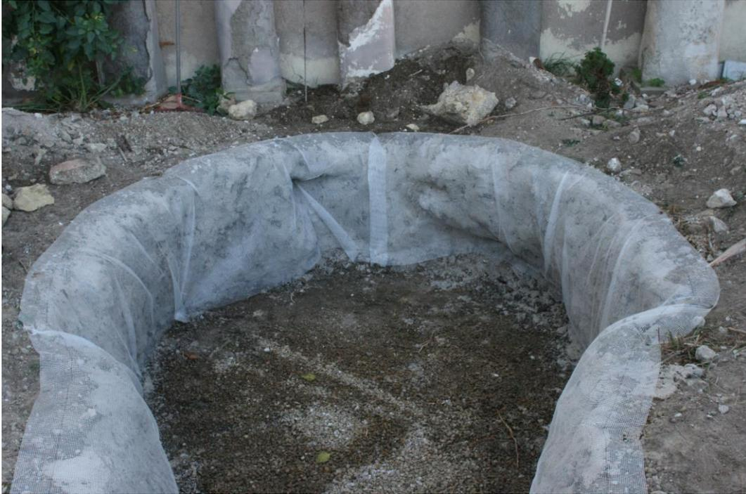
**Fig. 48 - Corti Beccia (Sanluri): consolidamento delle pareti.**
