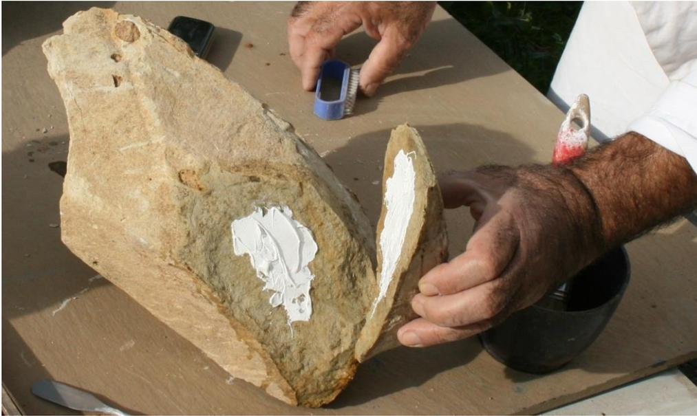
**Fig. 46 - Corti Beccia (Sanluri): restauro degli elementi lapidei prima del posizionamento.**
