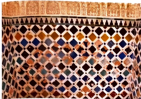
Paño de alicatados en la esquina sureste del Patio de Comares. © María Elena Díez Jorge.
