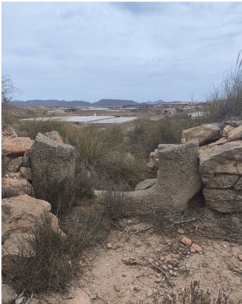
Fig. 57. Puerta perforada de acceso a la cámara de El Barranquete 9
