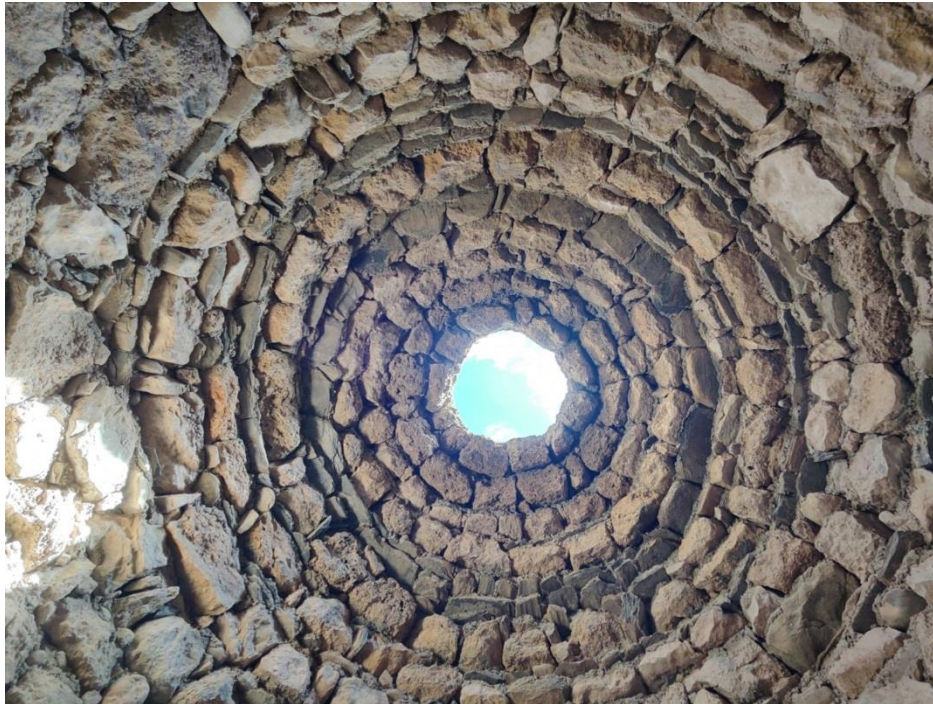
Fig. 40. Falsa cúpula sin el cierre de Lis Millares 17-I
