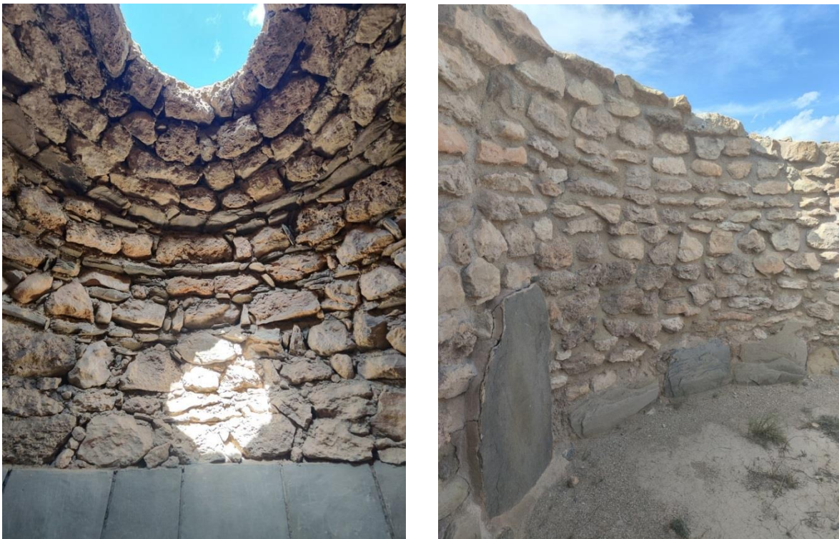
Fig. 39. Izquierda. reconstrucción de la aproximación de hiladas para la falsa cúpula de LM 17-I. Derecha, reconstrucción del revestimiento de ortostatos y el alzado de mampostería de LM 40-XXXVI
