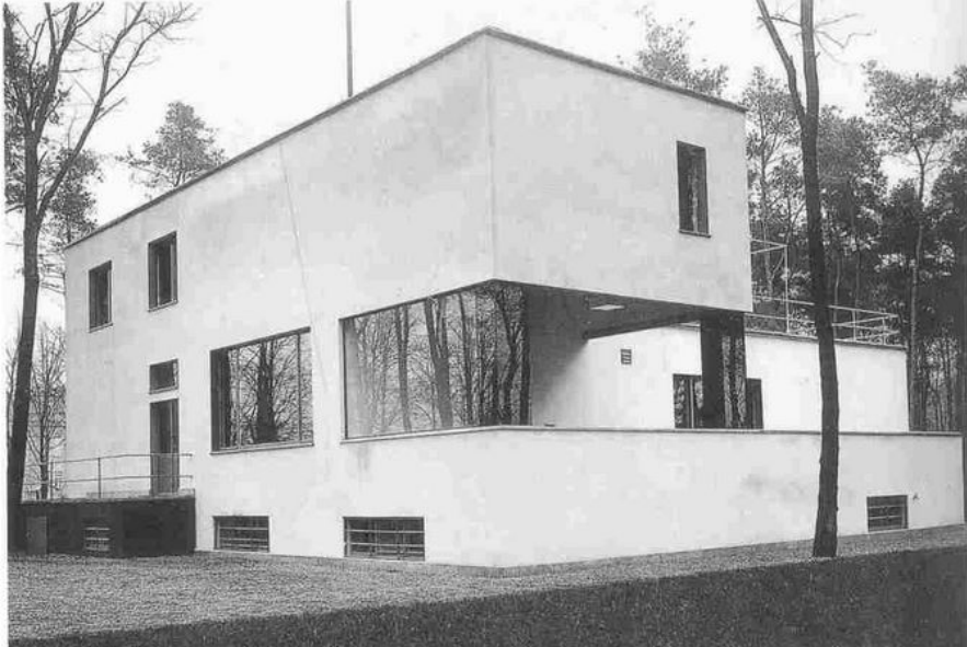
Figura 30. Imagen exterior de la vivienda de Walter Gropius dentro de la Bauhaus. Autor Bauhaus-Archiv. Año 1938.
