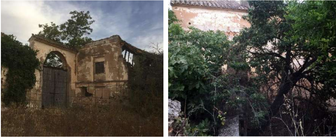
Figura 43. Figura 43A. Cortijo abandonado en la Vega de Antequera. Figura 43B: Higuera, peral y noguera en el patio interior. Fuente: elaboración propia, 2019
