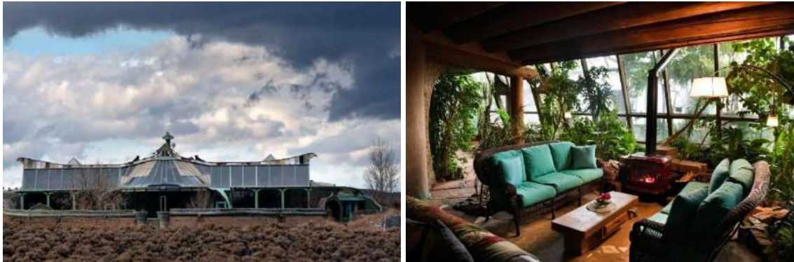
Figura 363. Earthship por fuera (izquierda) y por dentro (derecha) en Phoenix (Arizona). Fuente: earthshipbiotecture.com , 2020-2023
