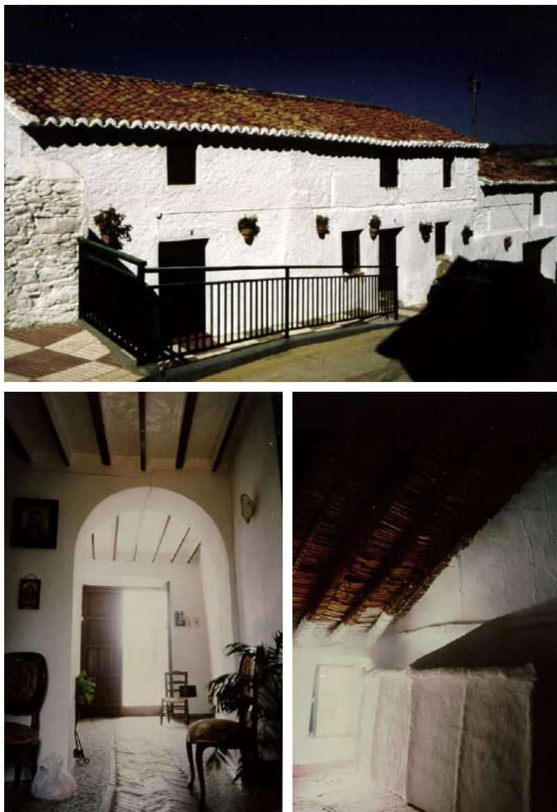
Figura 57. De arriba abajo y de izquierda a derecha. Figura 57A. Exterior de una casa tradicional en Casabermeja. Figura 57B. Entrada de la casa con el empedrado (en este caso cerámico). Figura 57C. Cámara de la casa donde se aprecia el techo de cañizo. Fuente: Pilar Ordóñez Vergara, 1994
