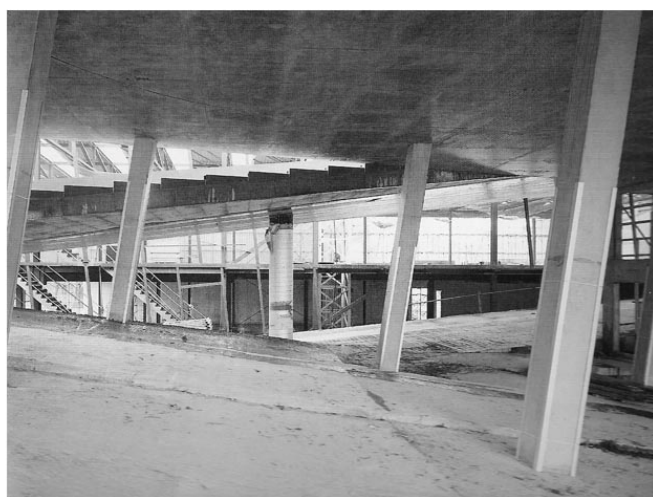
Figura 13. Los suelos y pilares inclinados de la Kunsthal en Rotterdam, fotografía de la obra (1992), según proyecto de OMA (Rem Koolhaas): KOOLHAAS 1992: 116
