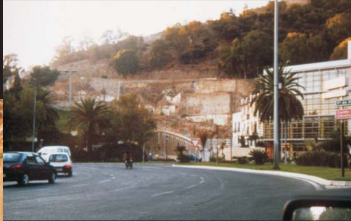
estado previo subida a la coracha
