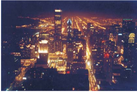
8.14. Vista hacia el Sur desde la Hancock Tower
