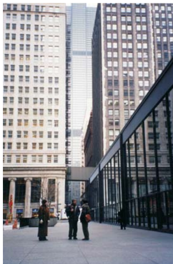
8.20. Federal Center Vista hacia el Oeste
