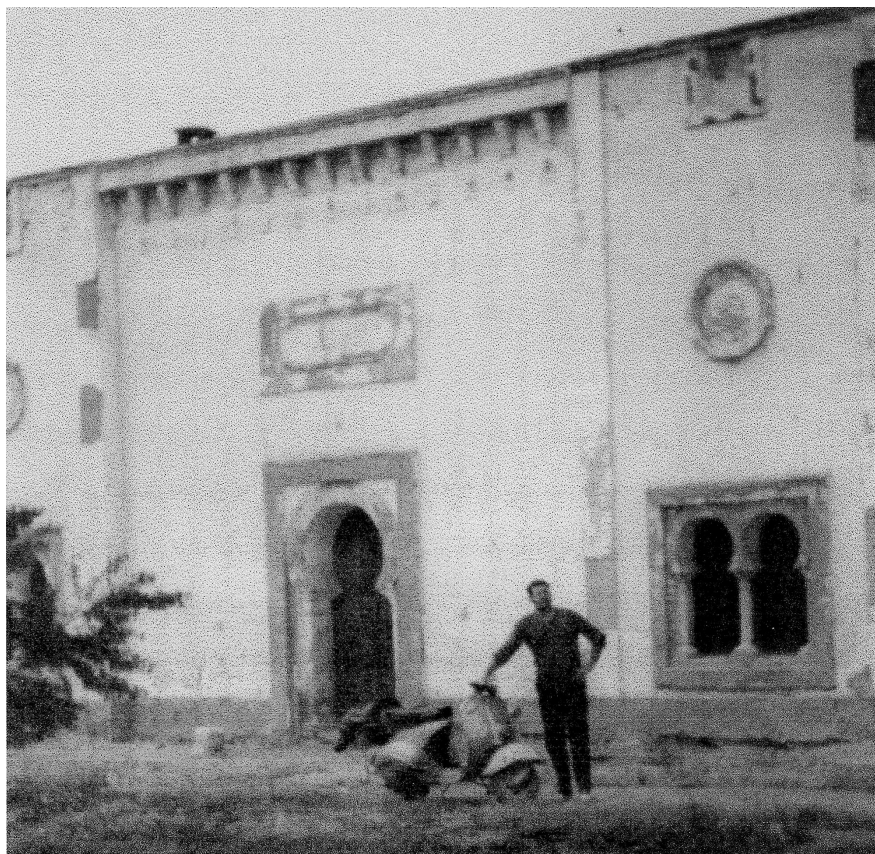
Figura 6. Fachada principal, puerta y ventana, años 60, en la que se pueden apreciar evidentes signos de abandono de la Cueva del Magistral. Fuente: José Terriza Moro.
