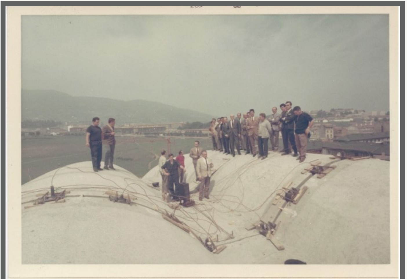
IMAGEN 3. Palacio de Deportes Durante las Obras. Fuente: Archivo Municipal de Oviedo.
