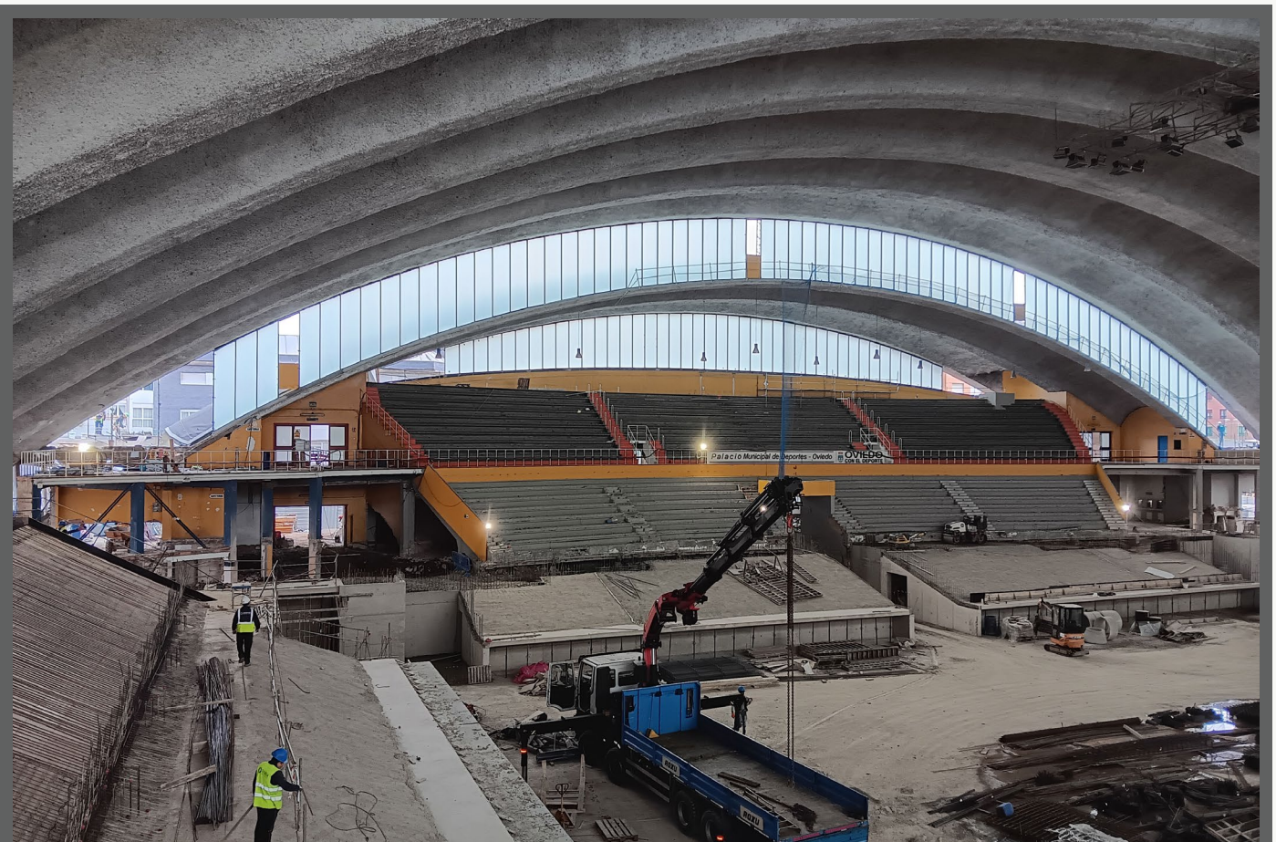
IMAGEN 9. Palacio de Deportes: Obras de Rehabilitación 2024. Fuente: Foto va Arquitectos.
