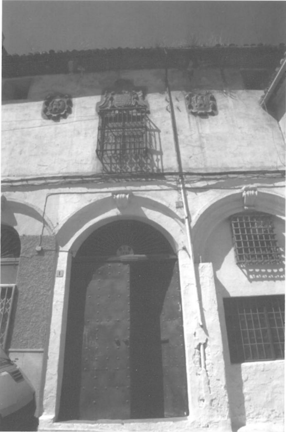
3.—Edificio del Pósito en Loja. Granada
