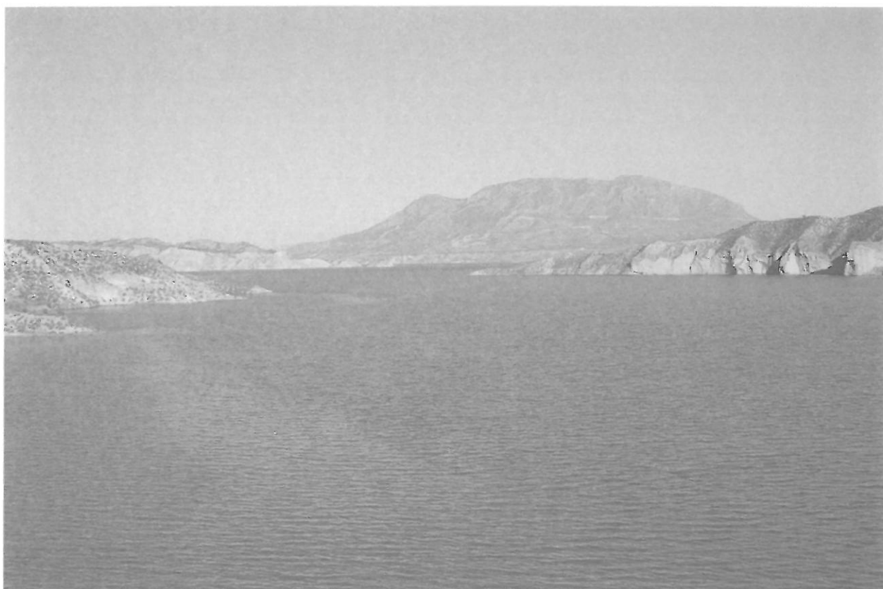
Fig. 4. Embalse del Negratín. Infraestructura en torno a la cual girará el desarrollo de muchas de las poblaciones de la comarca.
