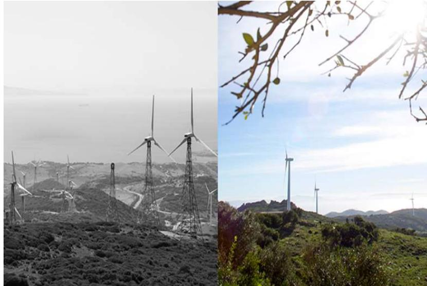
Fig.10. Vistas antes y después de la renovación del Cabrito. Fuente: Acciona.
