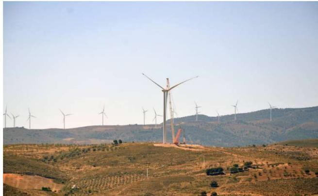
Fig.1. Instalación de las aspas del aerogenerador Mamut, en segundo plano uno de los parques eólicos que lo rodean. Fuente Ideal.
