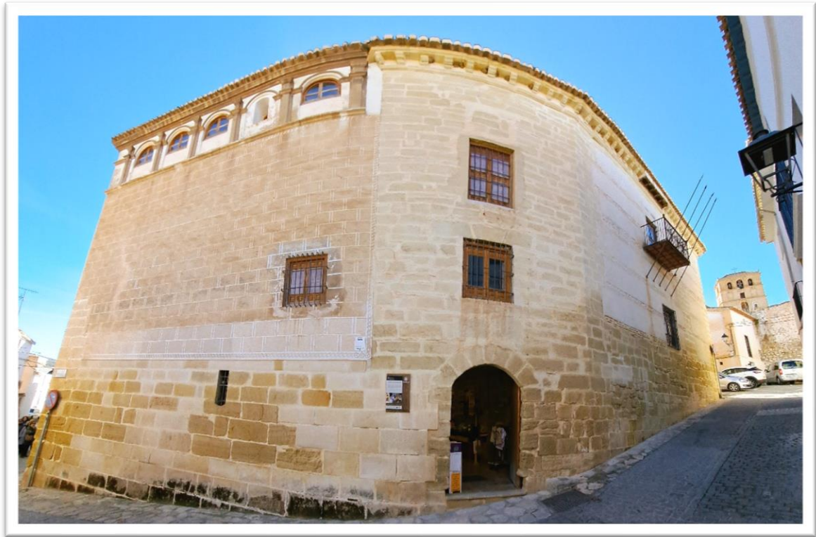
Imagen 46. Fotografía del hospital de la Reina en Alhama de Granada. Fue el primer hospital de sangre construido en Granada, edificado sobre una construcción de época islámica. Fuente: Elaboración propia.
