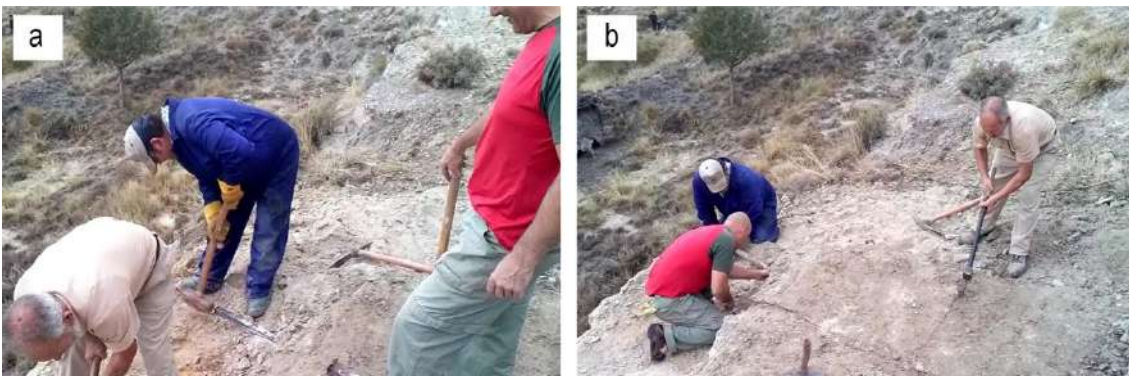
Figura 121. Proceso de extracción de grandes bloques de yeso utilizando un barrón y cuñas: a) barrón para hacer palanca; b) cuñas a lo largo de la línea de separación de la piedra. Fotografías del autor.
