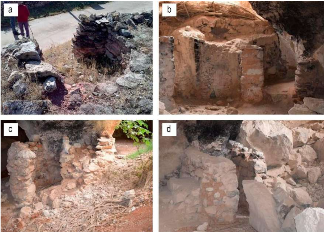
Figura 102. Hornos tradicionales circulares (tipo A) localizados en: a) Bara (Huesca); y b) - d) las distintas cuevas de Villalba Alta (Teruel). En la imagen (b) se puede distinguir un horno vacío (izquierda) y otro lleno (derecha), preparado para ser calcinado a través de la boca que dispone en su zona baja. Fotografías del autor.
