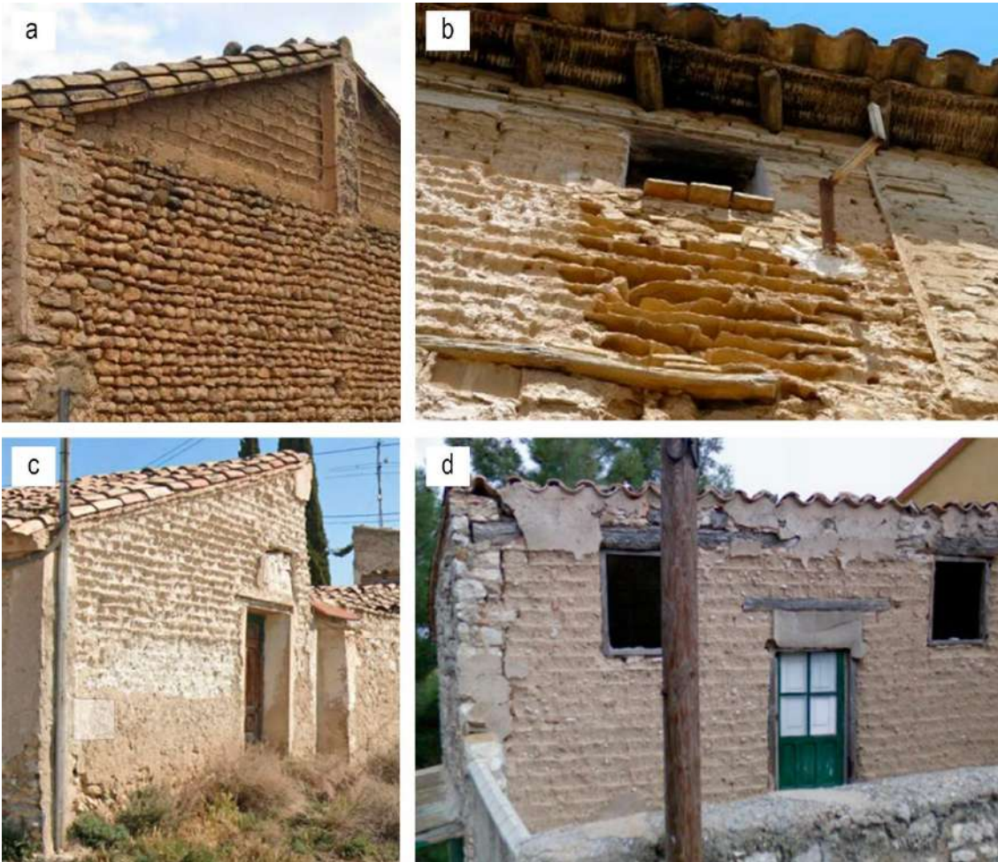
Figura 62. Juntas de adobe sin revestimiento en a) Lanaja (Huesca) y b) Tamarite de Litera (Huesca). Juntas de adobe con revestimiento en c) Villamayor de Gállego (Zaragoza) y d) El Buste (Zaragoza). Fotografías del autor.
