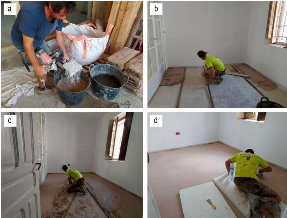
Figura 143. Aplicación en obra de yeso tradicional en superficies horizontales (pavimentos): a) dosificación de la mezcla yeso/agua con una relación cercana al 0,6 utilizando una batidora mezcladora motorizada; b) colocación de los niveles; c) aplicación del yeso sobre el suelo; d) correcciones para una terminación lisa y horizontal. Fotografías del autor.
