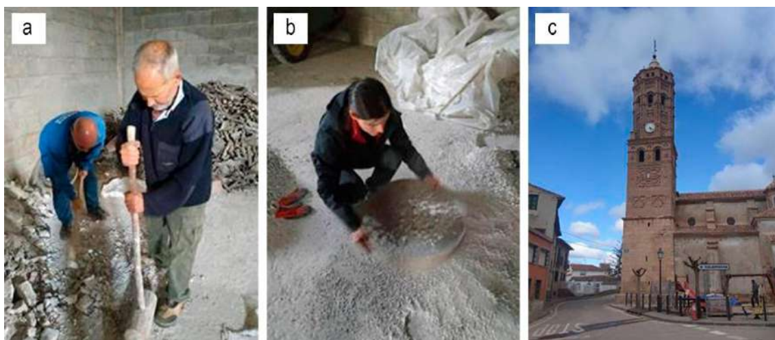
Figura 137. Imágenes del proceso de restauración de la iglesia: a) triturado del yeso; b) tamizado del yeso; c) estado restaurado. Fotografías del autor.
