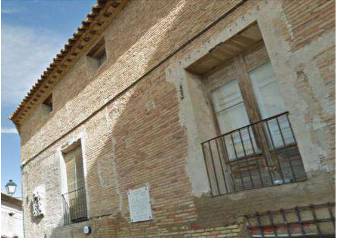
Figura 61. Mortero para reparaciones y rejuntado de grietas en La Ginebrosa (Teruel). Fotografía del autor.
