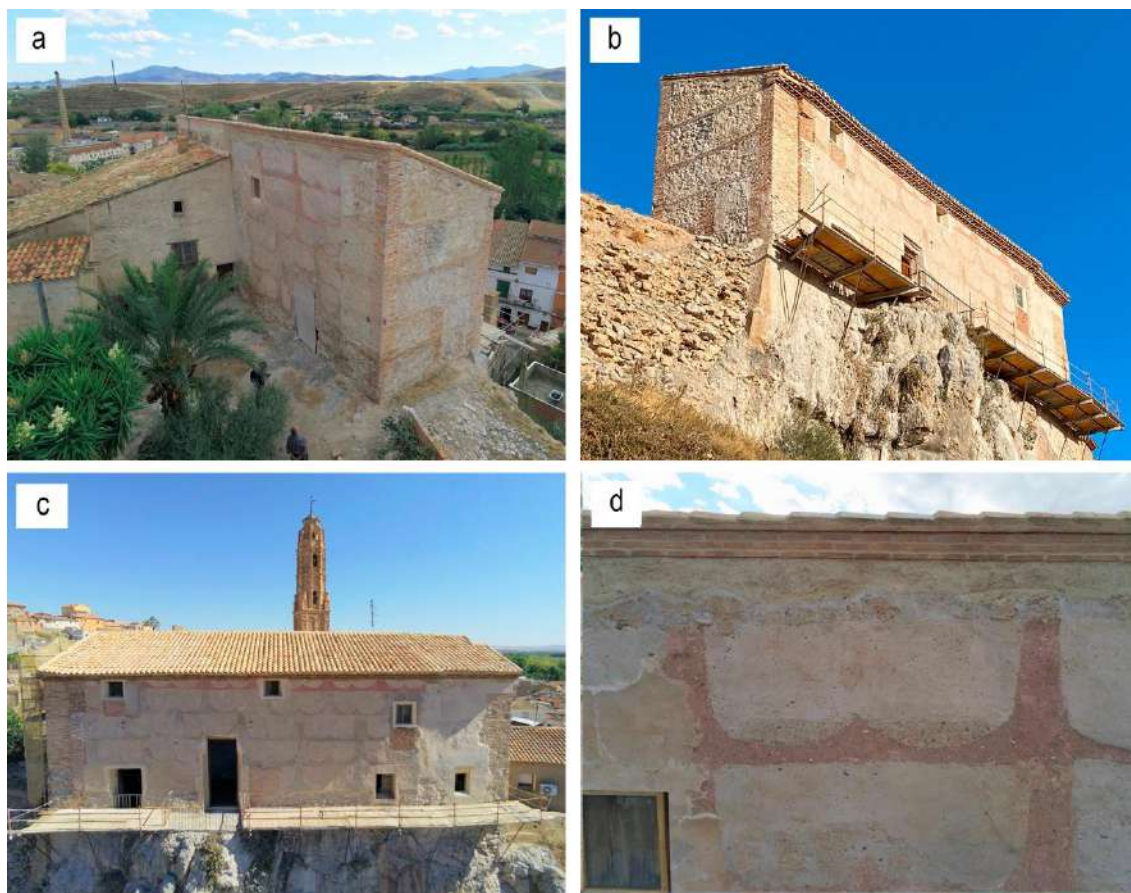
Figura 140. Estado tras la finalización de los trabajos de restauración: a) vista general; b) y c) fachada sur; d) detalle del estado final de las brencas. Fotografías del autor.
