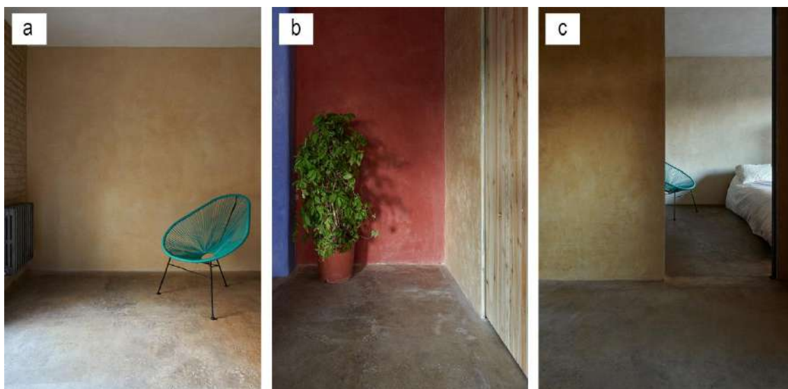
Figura 142. a) - c) Aspecto final del pavimento de yeso. Fotografías propiedad del autor, tomadas por Iñaki Bergera Serrano.
