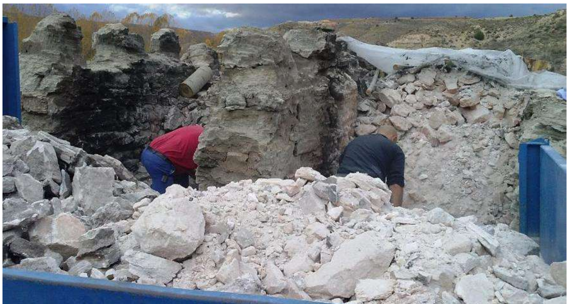
Figura 181. Proceso de desmontaje de los hornos tradicionales (izquierda: Navarrete, derecha: Albarracín). Visualmente ya se puede apreciar una clara distinción cromática de las piedras obtenidas, de modo que en el horno de Navarrete las piedras tienen un color grisáceo, correspondiente a los 300-400°C, mientras que en el de Albarracín se observa una tonalidad salmón, propia de cocciones a 700°C.
