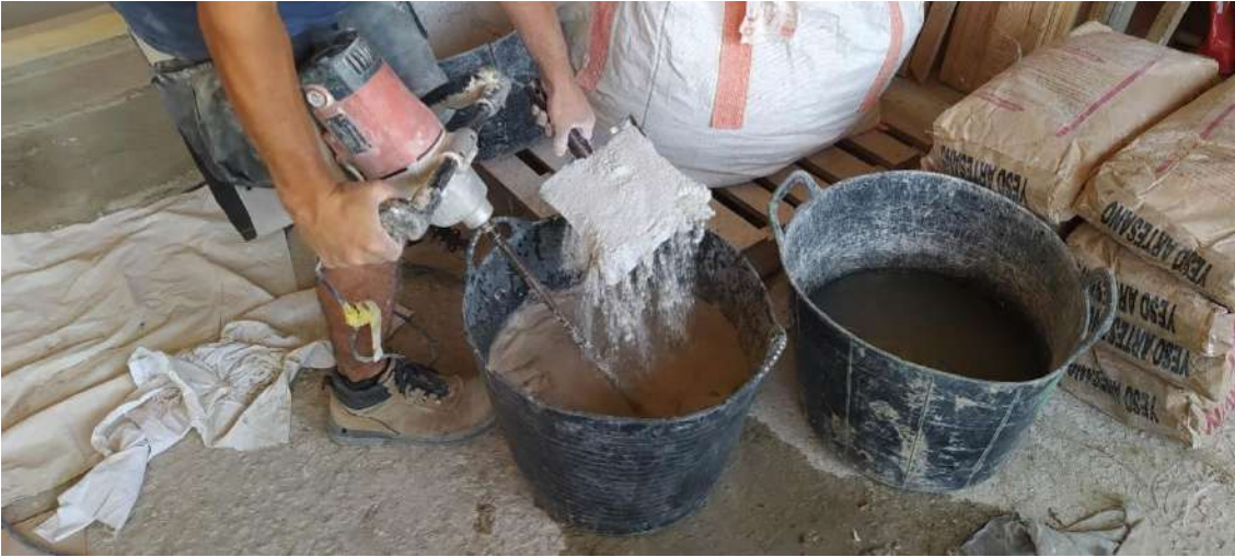
Figura 119. Utilización de nuevos elementos modernos como los cubos de plástico y las batidoras motorizadas durante la realización de una de las aplicaciones experimentales. Fotografía del autor.
