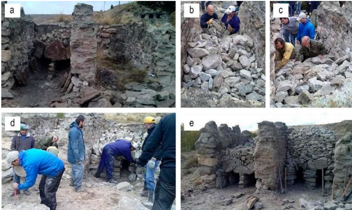
Figura 105. Distintas imágenes del levantamiento de los hornos en Navarrete (Teruel) en 2016: a) levantamiento de los muros y ejecución de dinteles en el horno de Navarrete (izquierda); ejecución de las bóvedas en el horno de Albarracín (derecha); b) - d) colocación del material de cantera en los hornos, donde se aprecia un material homogéneo de buena calidad, sin demasiadas vetas visibles que indicarían la presencia de minerales accesorios; e) hornos concluidos y rellenos con el material de cantera para su cocción. Fotografías del autor.
