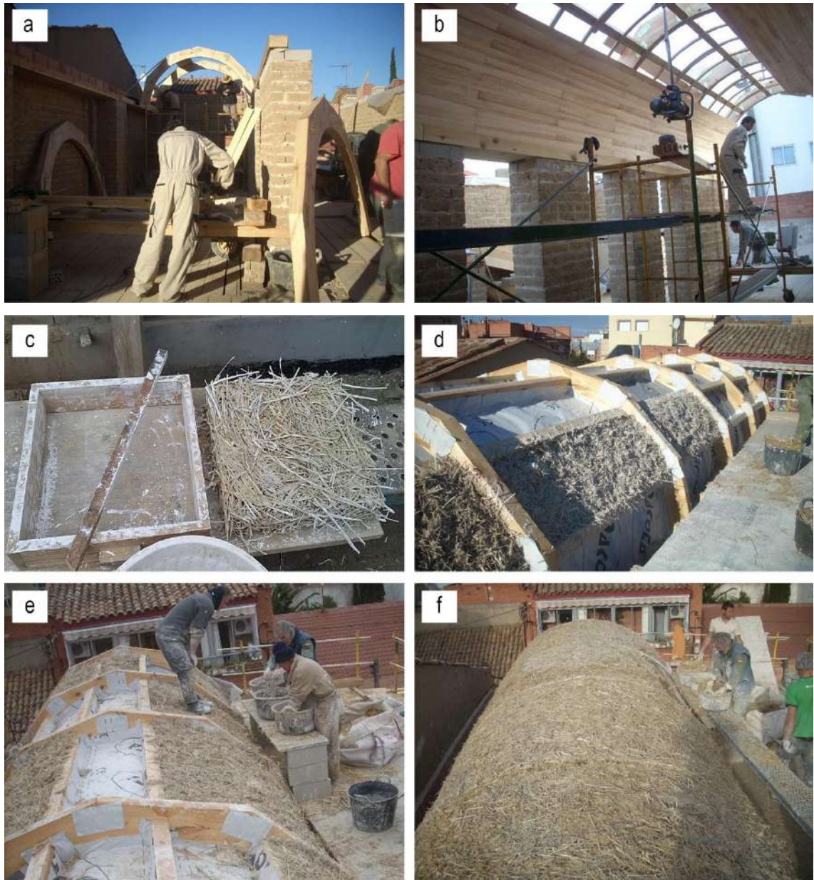
Figura 148. Imágenes durante el proceso de construcción de la bóveda: a) montaje de los arcos de madera; b) encofrado inferior mediante el tablero de madera de acabado interior; c) pruebas de amasado in situ con yeso, agua y paja; d) y e) aplicación del yeso tradicional mezclado con paja sobre la bóveda; f) estado final. Fotografías del autor.
