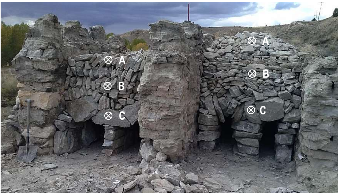
Figura 164. Ubicación de las distintas piedras de yeso en los hornos tradicionales, extraídas para su estudio mediante las técnicas analíticas. A: zona alta o caramullo; B: zona media; C: zona baja o boca. Fotografía del autor.
