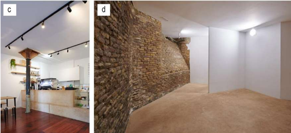
Figura 146. Imágenes de la obra de reforma finalizada: a) barra/mostrador de yeso y rejuntado de muros interiores de ladrillo; b) y c) detalle de la barra/mostrador; d) pavimento de yeso en la planta inferior. Fotografías propiedad del autor, tomadas por Iñaki Bergera Serrano.
