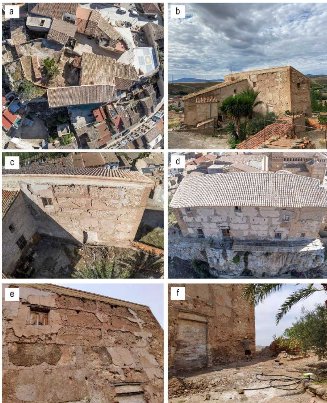
Figura 138. Estado original del castillo previo a la rehabilitación: a) y b) implantación en el entorno: nave principal y un cuerpo adosado; c) estado previo de la fachada norte; d) estado previo de la fachada sur; e) y f) detalle del estado previo de las decoraciones con breccas realizadas con yeso. Fotografías del autor.
