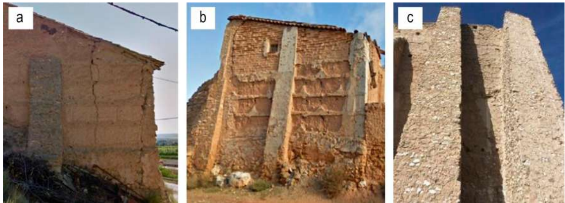
Figura 73. Contrafuertes en a) Terrer (Zaragoza), b) Fuentes de Jiloca (Zaragoza) y c) Rodén (Zaragoza). Fotografías del autor.
