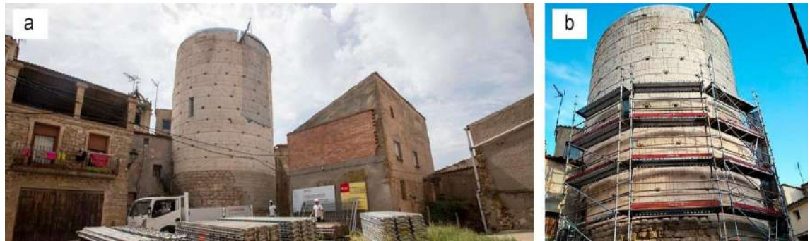
Figura 83. a) Estado de la torre tras la restauración (Lleida.com, 2020); b) incorporación de andamios por el desprendimiento del mortero (Somsegarra, 2020).
