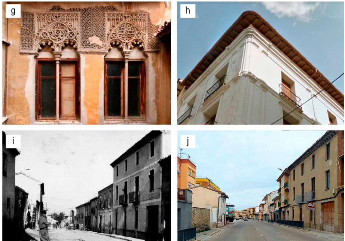
Figura 55. a) Elementos decorativos exteriores esculpidos o agramilados en Maluenda (Zaragoza). Elementos decorativos exteriores en ventanas y huecos en b) Nueno (Huesca), c) Maluenda (Zaragoza). Elementos decorativos exteriores en cornisas en d) Fuentes de Ebro (Zaragoza). Elementos decorativos exteriores en g) Daroca (Zaragoza) y h) Calatayud (Zaragoza). Detalles decorativos exteriores en e) Caspe (Zaragoza) y f) Daroca (Zaragoza). i) y j) Elementos decorativos exteriores en alero y huecos, perdidos en la actualidad en una vivienda tradicional de tres plantas en Zuera (Zaragoza): i) imagen histórica; j) imagen actual. Fotografías del autor.
