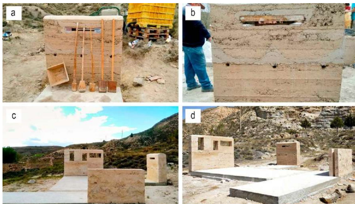
Figura 157. Resultado final del muro de tapia: a) muro de tapia donde son visibles las brenchas de yeso; b) detalle de las brenchas; c) y d) conjunto de los tres muros de tapia finalizados. Fotografías del autor.
