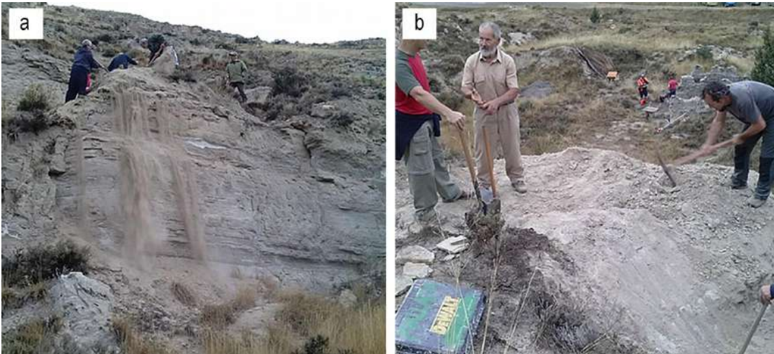
Figura 120. a) y b) Retirada de la primera capa de yeso arenizado. Fotografías del autor.
