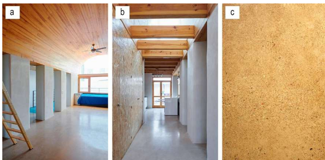
Figura 149. Diferentes acabados interiores realizados con yeso tradicional: a) y b) pavimento de pasillo y salón; c) paredes del baño. Fotografías propiedad del autor, tomadas por Iñaki Bergera Serrano.
