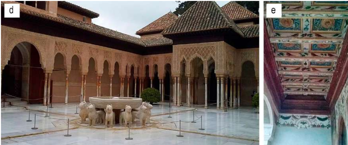
Figura 32. Distintos ejemplos del extendido uso del yeso en la Alhambra (Granada): a) elementos decorativos “en cascada” en la cúpula de mocárabes en la Sala de las Dos Hermanas; b) y c) yeserías en el Patio del Cuarto Dorado; d) aplicaciones decorativas con yeso en exteriores en los pórticos del Patio de los Leones; e) motivos decorativos pintados sobre yeso revistiendo la estructura de madera en el techo de la sala del Peinador de la Reina. Fotografías del autor.
