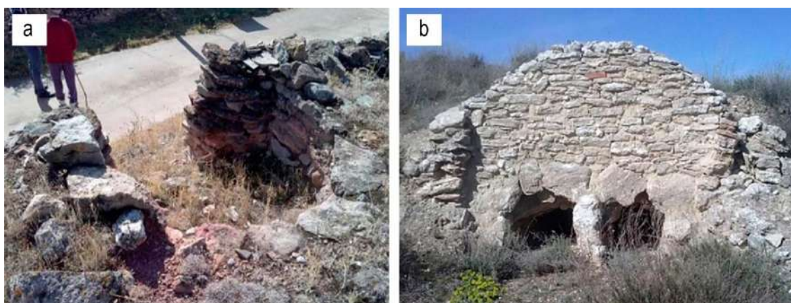
Figura 100. Hornos tradicionales: a) horno circular abandonado (tipo A, Bara, Huesca); b) horno rectangular (tipo B, Leciñena, Zaragoza). Fotografías del autor.
