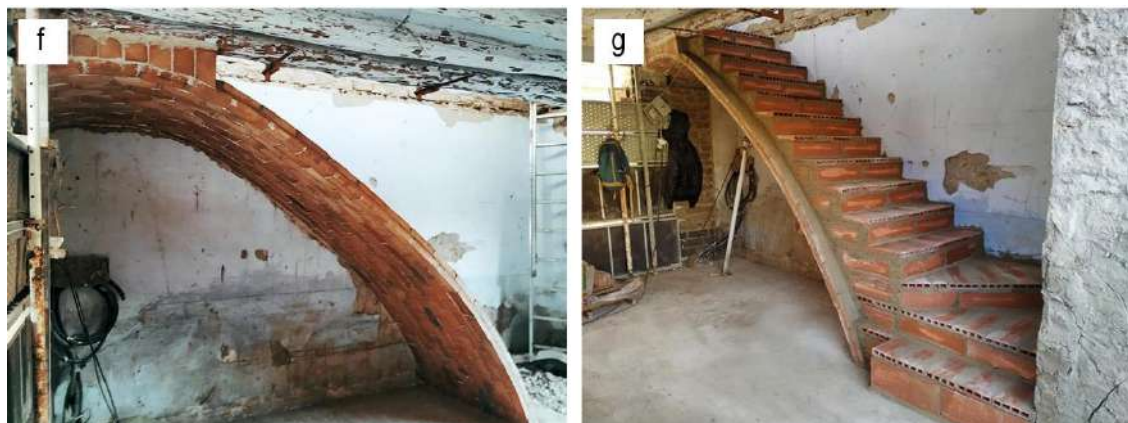
Figura 151. Construcción de la escalera con bóveda tabicada empleando yeso en las juntas de las piezas cerámicas: a) - c) ejecución de la primera rosca con piezas cerámicas cogidas con yeso, donde se aprecia la gran rapidez del yeso que permite la realización de la bóveda sin necesidad de apuntalar; d) y e) comienzo de la segunda rosca sobre la primera; f) bóveda tabicada terminada; g) colocación de peldaños sobre la bóveda tabicada. Fotografías del autor.
