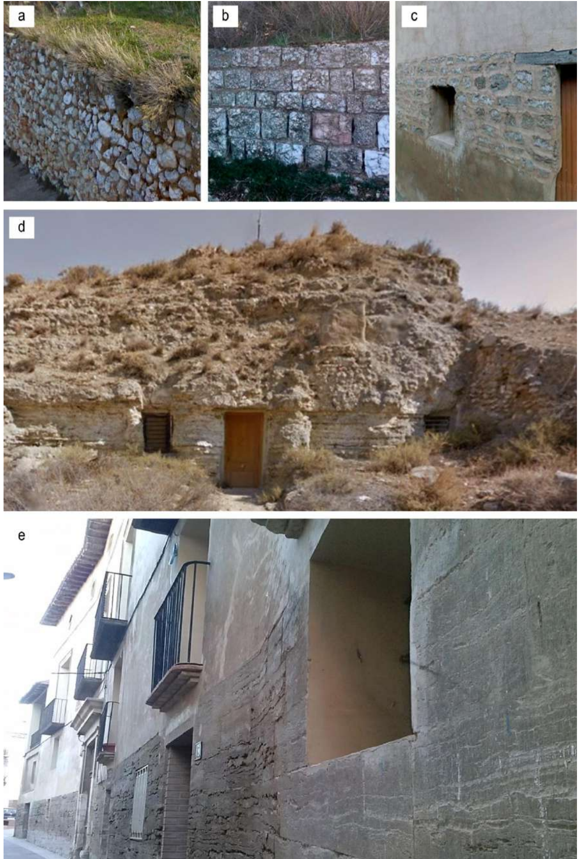
Figura 75. a) Piedra mampuesta en Fuentes de Jiloca (Zaragoza). Piedra labrada o canteada en b) Rodén (Zaragoza) y c) Alfajarín (Zaragoza). Piedra excavada en d) Bardallur (Zaragoza). e) Fachada de una vivienda realizada con piedra de yeso pulida en San Esteban de Litera (Huesca), municipio que perfeccionó esta técnica en la que originalmente las piedras serían más blancas y de aspecto similar al mármol. Fotografías del autor.
