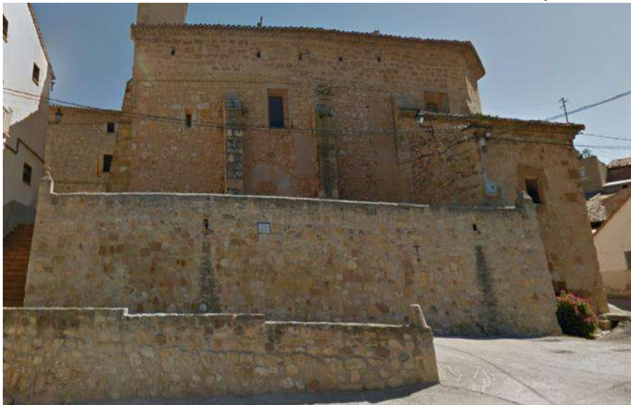
Iglesia de Cañada de Verich
