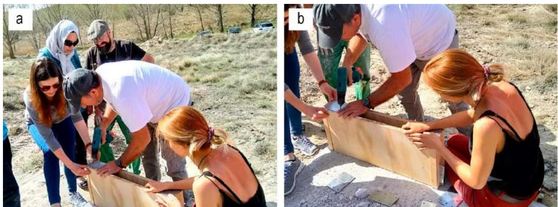
Figura 158. a) y b) Preparación de los moldes para la realización de adobes de yeso. Fotografías del autor.
