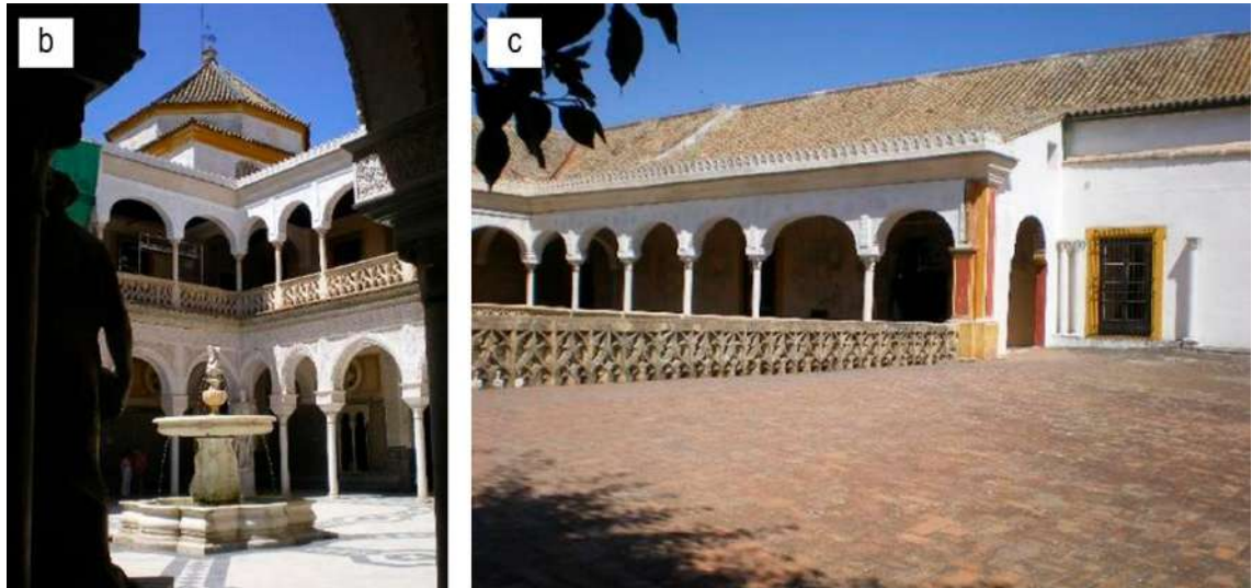
Figura 30. Distintos ejemplos de yeserías en pórticos en la ciudad de Sevilla: a) Patio del Yeso en el Alcázar de Sevilla (siglo XI); b) y c) Casa de Pilatos (siglo XV). Fotografías del autor.
