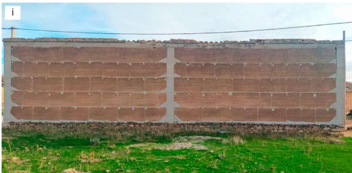
Figura 152. Distintos edificios en la zona central de Teruel, en los que se puede apreciar con claridad la técnica de tapia de yeso con breccas en a) - d) los alrededores de Calamocha (Teruel) y e) - i) los alrededores de Caminreal (Teruel). Fotografías del autor.
