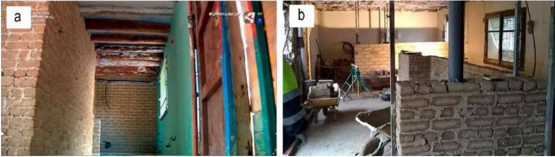
Figura 150. Imágenes de obra de la construcción de los tabiques con adobes cogidos con mortero de yeso: a) Aragón TV (2020); b) fotografía del autor.
