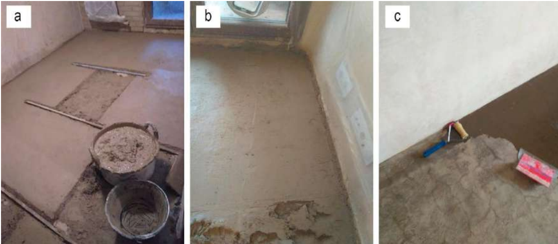
Figura 141. Aplicación durante la obra de pavimentos de yeso: a) regleado del yeso; b) yeso extendido previo al alisado; c) aplicación de aceite de linaza para el endurecimiento e impermeabilizado de la superficie. Fotografías del autor.
