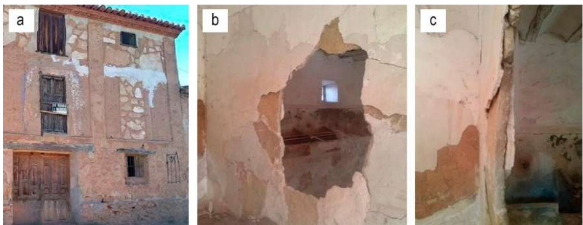
Figura 59. a) Tabiques de piedra de yeso (aljezones) en Mas de las Matas (Teruel), y b) y c) en Libros (Teruel). Fotografías del autor.
