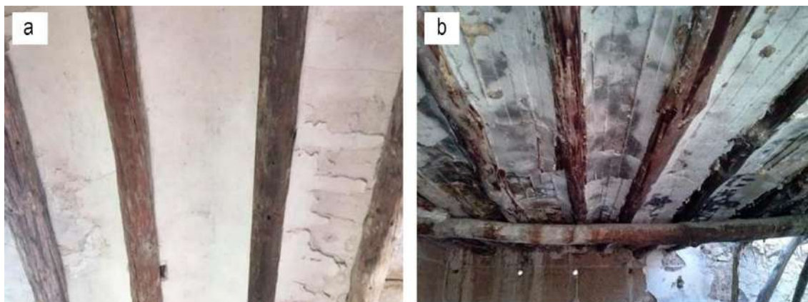
Figura 67. Forjados de yeso encofrado y vertido en a) Terror (Zaragoza) y b) La Ginebrosa (Teruel). Fotografías del autor.
