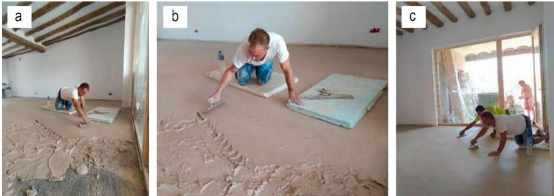
Figura 144. a) - c) Aplicación en obra de yeso tradicional en superficies horizontales (pavimentos). Fotografías del autor.
