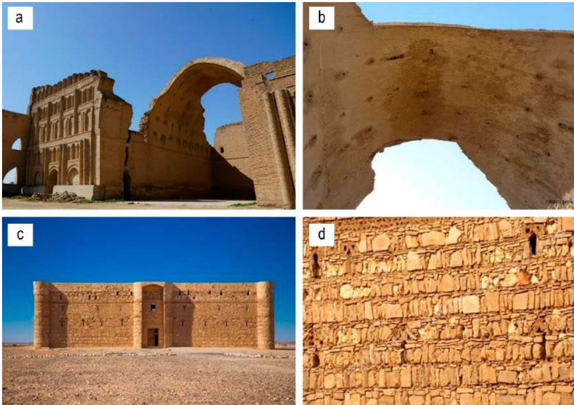
Figura 24. a) Restos del Iwan del Palacio de Cosroes (hanming_huang, 2019); b) sistema constructivo de la bóveda construida a bofetón sin cimbra, únicamente con ladrillo y mortero de yeso como conglomerante, en el Iwan del Palacio de Cosroes (Almagro Gorbea, 1986) (Tobeytravels, 2013); c) fachada exterior del Castillo Qasr Kharana donde según Almagro Gorbea (1986) se empleó el yeso como conglomerante entre juntas de piedra (Etienne Valois, 2013); d) detalles en la fachada del Castillo de Qasr Kharana (Travel around Spain, 2016).
