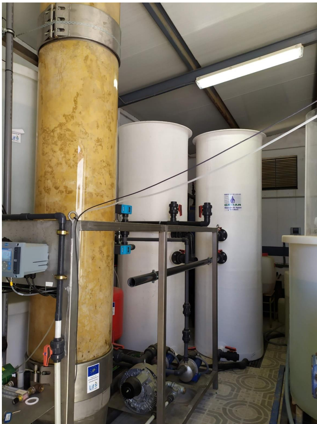
Imagen 2: Planta demostrativa con tecnología granular aeróbica secuencial
