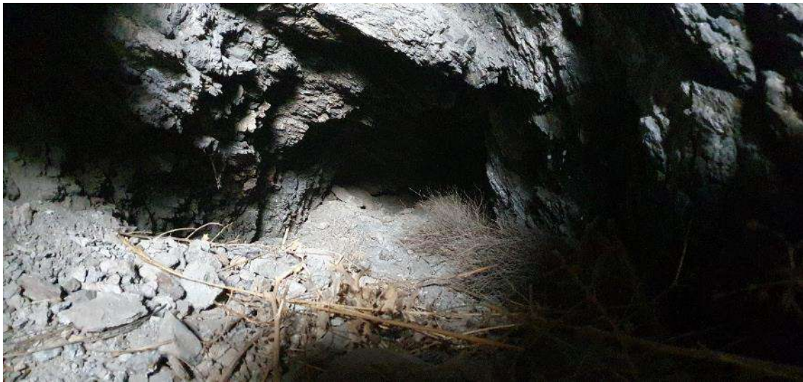
Figura 265 Galería semi colmatada, al NO de Gérgal, por encima de la carretera de acceso a la población. Foto por el autor.
