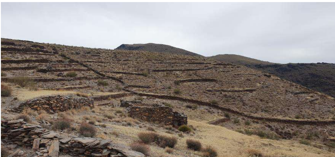
Figura 238 Parte occidental del sistema, donde se aprecian los corrales con parideras insertos en este. Foto por el autor.
