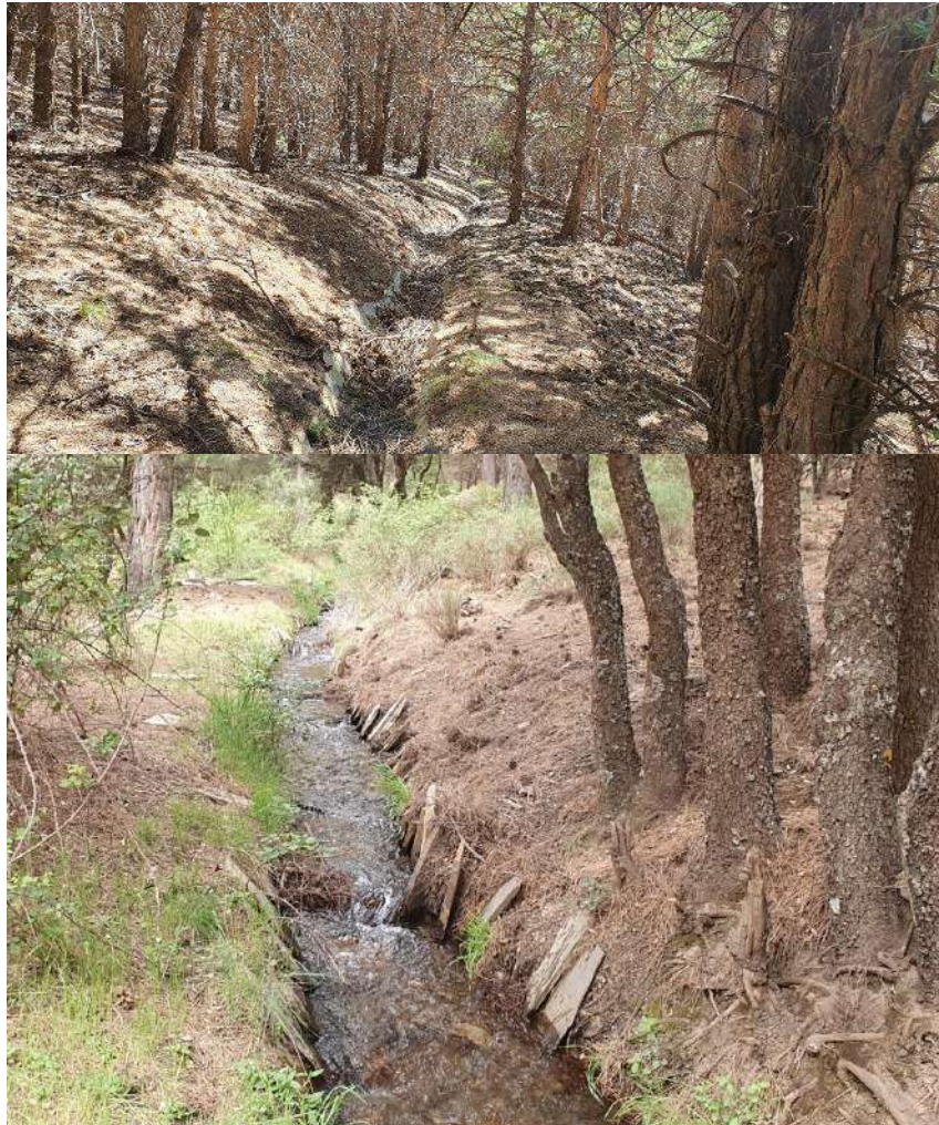
Figura 57 Dos tramos de la Acequia del Jaral, en la que se aprecia el abandono de algunos de sus tramos más bajos. Fotografía por el autor.
