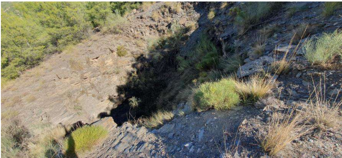
Figura 242 Enorme socavón fruto de la explotación contemporánea. Foto por el autor.
