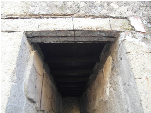
Figura 4. Viga de hormigón armado deteriorada en una casa de Herculano (foto del autor, 2020).
