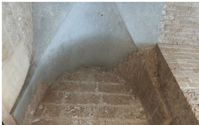
Figura 1. Bóveda reconstruida en hormigón de la Zisa de Palermo (foto del autor 2024).
