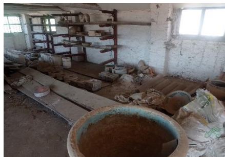
Il. 85. Detalle de la cámara cubierta, en su estado de deterioro actual. Imagen de autoría propia.
