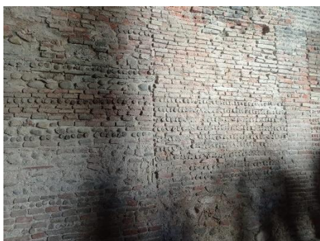
Il. 76. Detalle del muro en aparejo de mampostería. Imagen de autoría propia.
