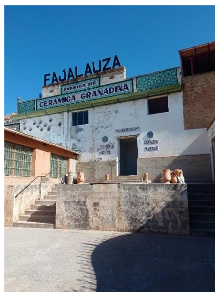
Il. 79. Detalle de la fachada interior de la fábrica de Fajalauza. Imagen de autoría propia.
