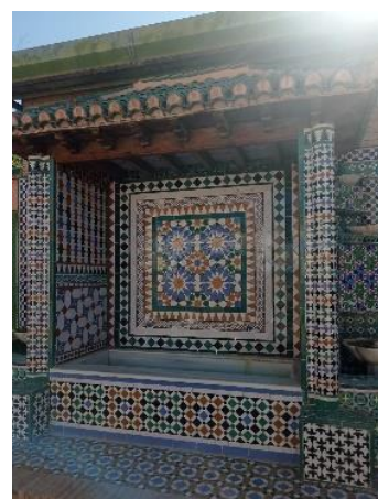
Il. 73. Detalle de la fuente del patio de acceso. Imagen de autoría propia.
