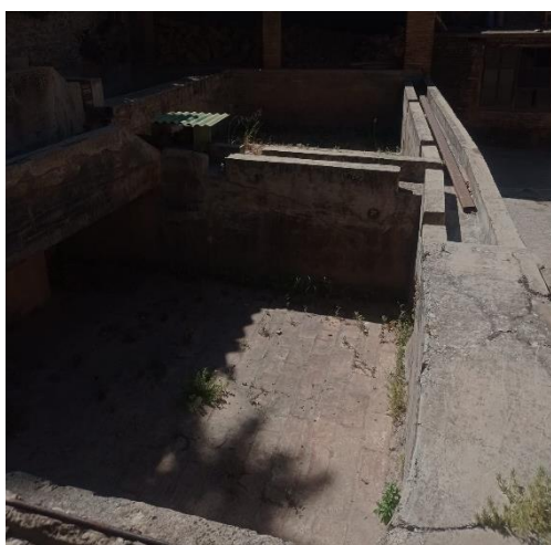
Il. 78. Detalle de las albercas de decantación. Imagen de autoría propia.
