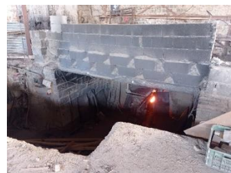
Il. 15. Detalle del horno encendido. Imagen de autoría propia.
