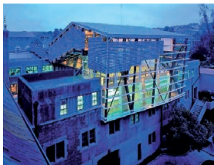
Valparaíso. Escuela de arquitectura SM Foto: Departamento de arquitectura USM
