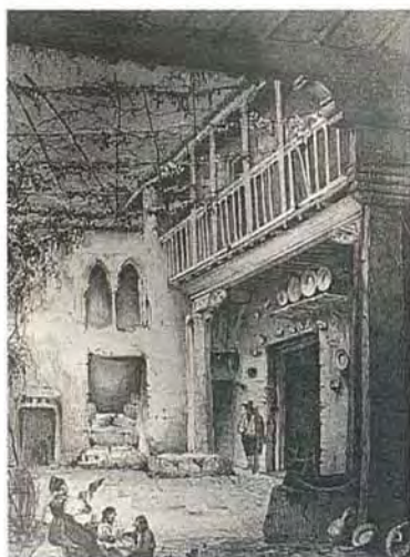
Patio de la casa del Chapiz.
