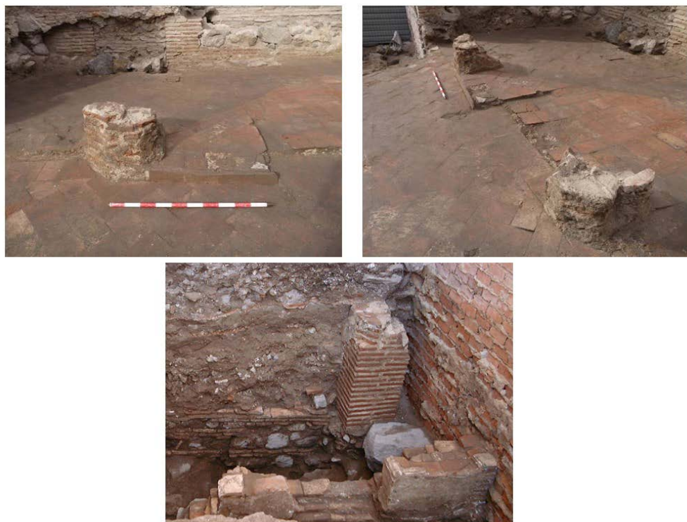
Figura 13. Pilares octogonales, la foto inferior pertenece a la intervención del nº 29 donde se aprecia claramente la cimentación del pilar (Caballero García y Sánchez Peláez, 2006).
