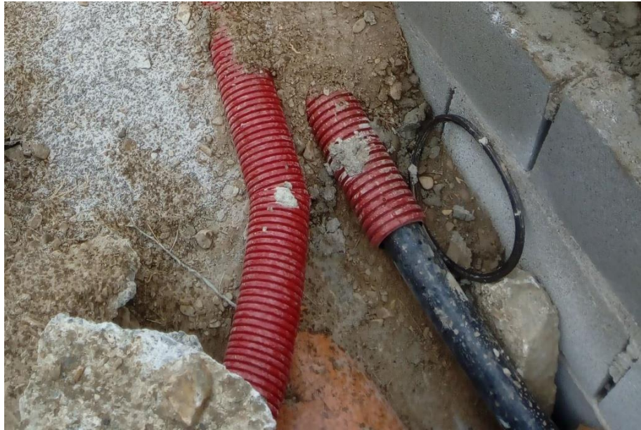
Figura 5. Tendido de tubería de agua encamisada dentro de una galería de servicios.
