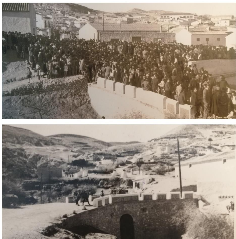
Figura 1. El primer puente que se construyó supuso simbólica y realmente el comienzo del desarrollo comunitario del Barrio de Las Cuevas de Baza. Toda la población salió a celebrarlo en su inauguración en la primavera de 1961.
