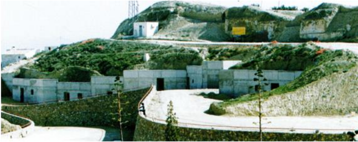
Figura 4. Casones rehabilitados en el Cerro del Castellar (T. M. Puerto Lumbreras).
