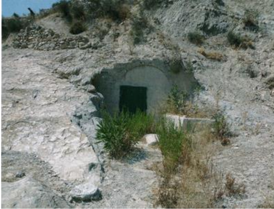
Figura 1. Bocamina de la Fuente de Benito, en la ladera suroccidental de Sierra del Oro (T.M. Abarán).
