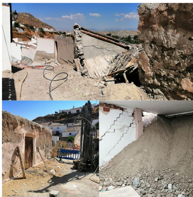
Figura 4. Relleno desde c/San Isidro para creación de plataforma de trabajo para la ejecución de los micropilotes.
