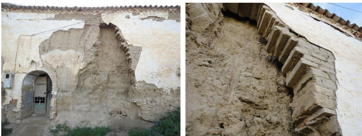
Figura 3. Fachada de obra elaborada con protoadobes. Detalle de los bloques de tierra sin fibras. 2020. Guadix, Granada. Elaboración propia.
