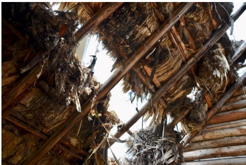
Figura 4. Vista interior de una techumbre con suadero. Pieras Blancas, Coah.
