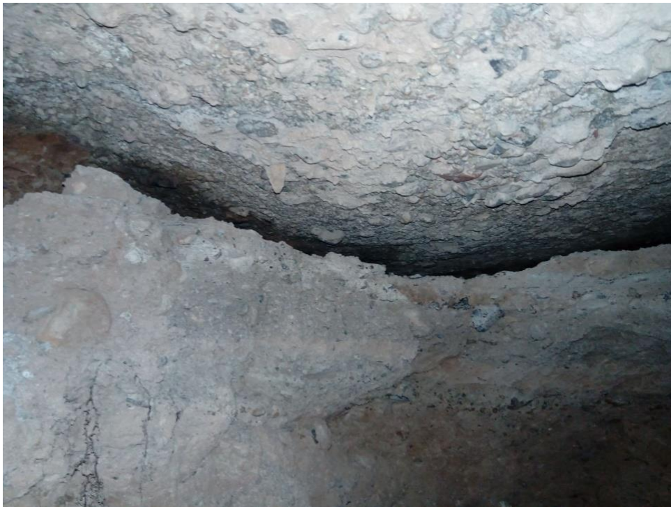
Figura 2. Hundimiento producido por escasez de montera (se aprecia la solería de hormigón del pavimento superior) y presencia de agua (existencia de raíces de plantas).
