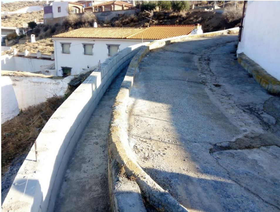
Figura. 4. Ejecución de galería de servicios aneja al pavimento existente.
