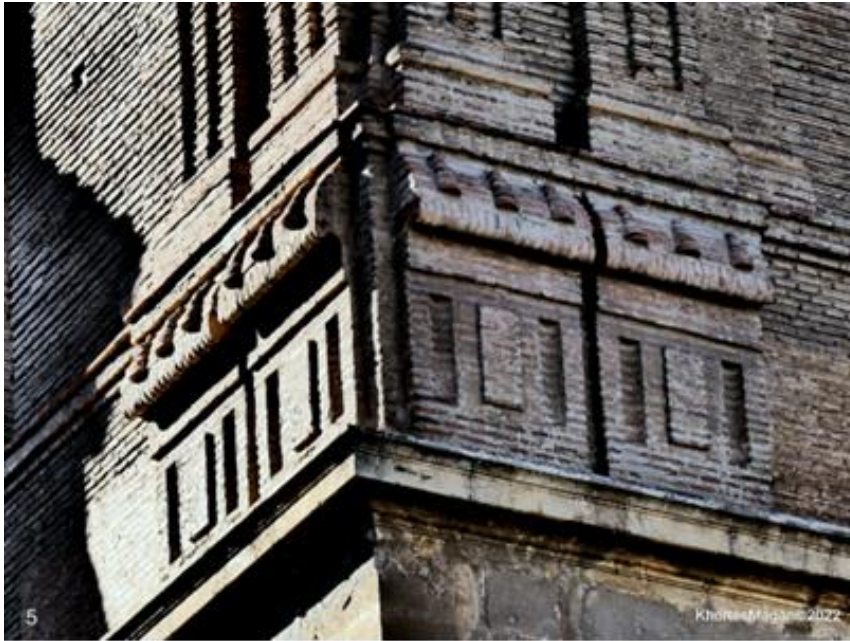
Figura 5 (Torre catedral de Guadix, ladrillo, foto: Manuel Cortés Magán).
