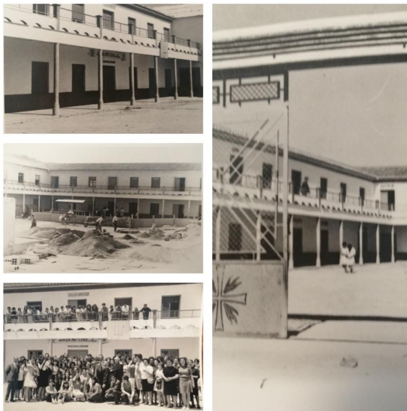
Figura 2. Centro Social del Ángel, base de operaciones del Plan Social Baza. Inicio de las obras en 1959. Inauguración el 15 de noviembre de 1963.
