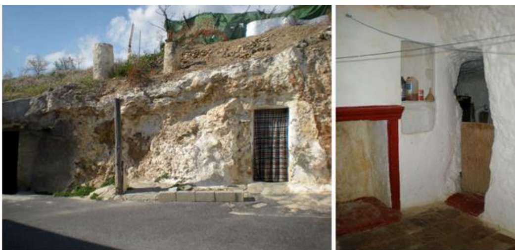
Figura 3. Fachada y vista interior de una casa cueva ubicada en la Calle Adrián López Iriarte de Padul. Fotografías de la autora, 2011.
