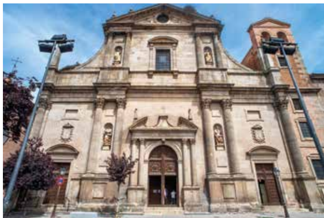
Fig. 15. Bartolomé de Bustamante y Francisco de Mora, Iglesia de Santa María (Compañía de Jesús) de Alcalá de Henares, 1567-1624. Foto Alamy
