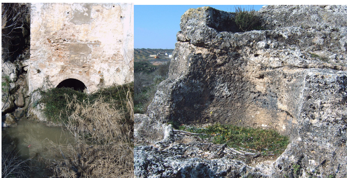
Entrada de agua en el Molino La Puente/ Piedra horadada por la extracción de piedras de molino (Iznalloz)
