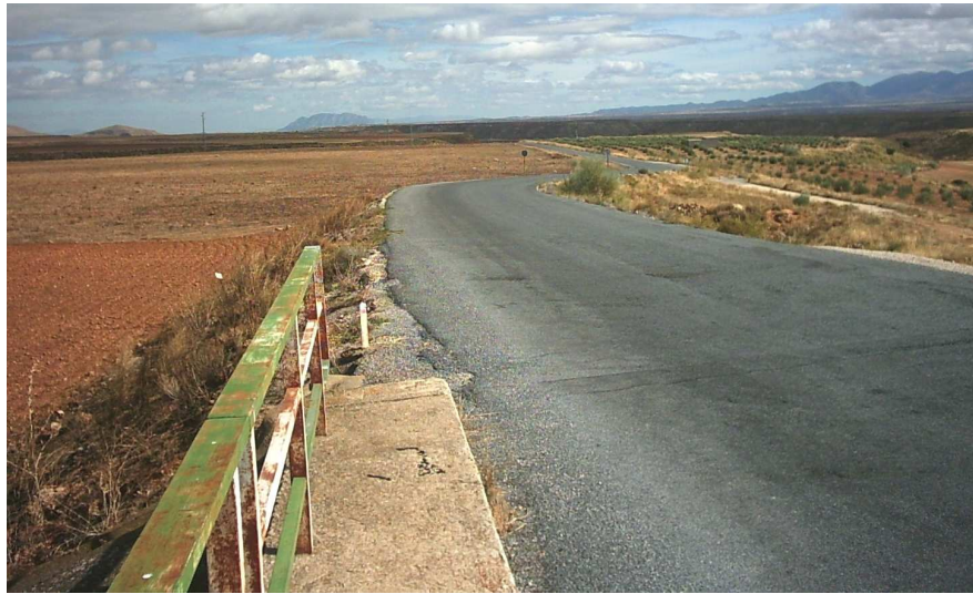
Acceso por la carretera comarcal NE 36 a Huélago.
