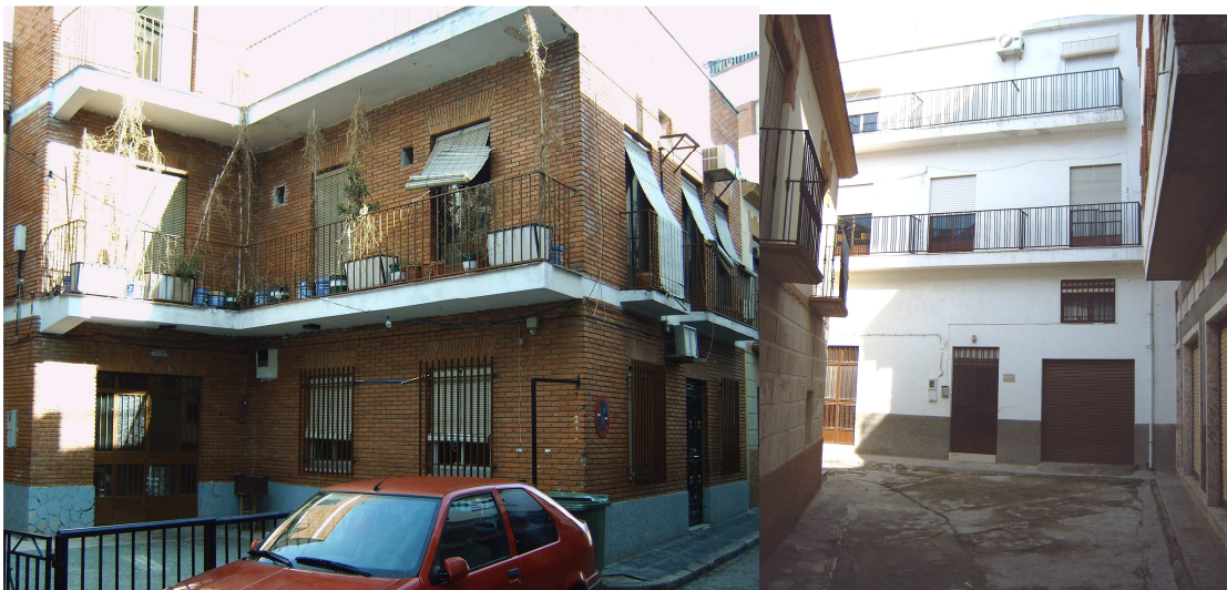
Casino Acatuccitano y Casa Rectoral, que alberga en su primera planta el Archivo Parroquial. Ambos edificios están en la misma calle del casco histórico, separados solamente por una vivienda.
