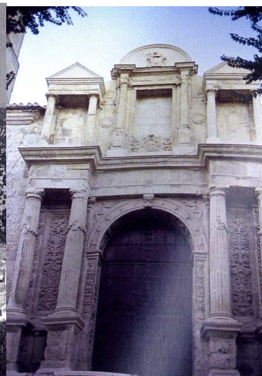
Fachada de la Iglesia de Guadahortuna.
