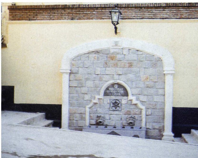
Pilar rehabilitado en 1998 gracias a una Escuela Taller.
