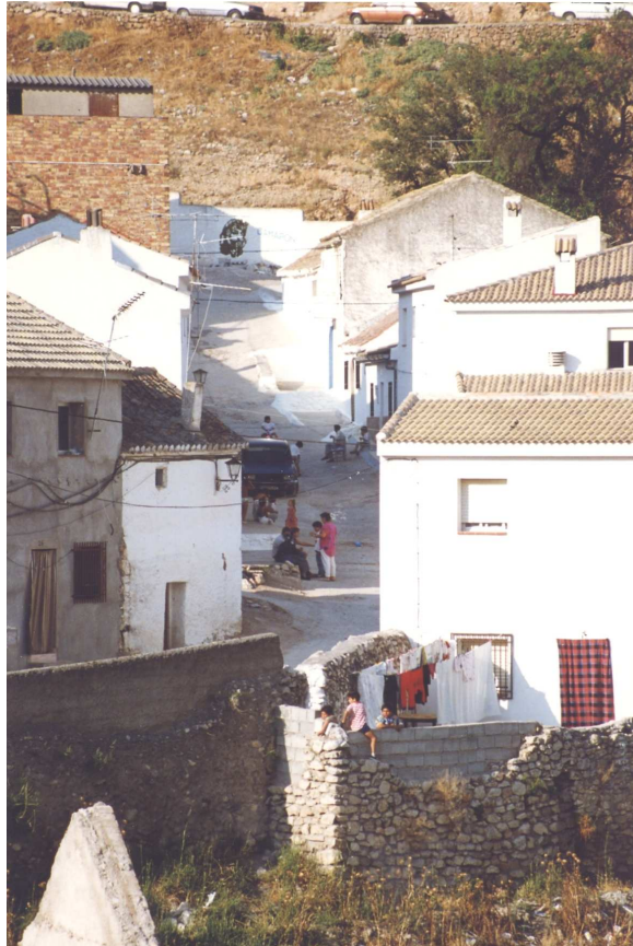
Barriada gitana de la comarca, en la que se distinguen las viviendas rehabilitadas por el Plan de Infravivienda.
