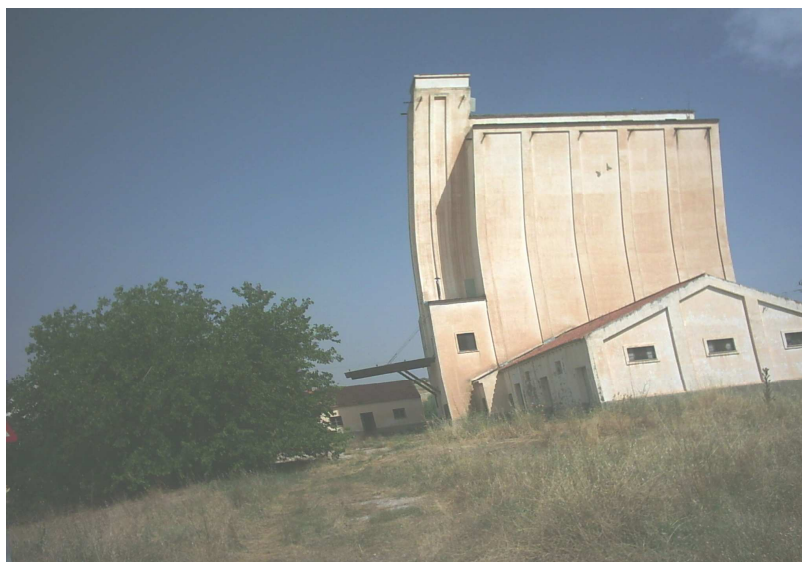
Silo de Moreda, junto a la Estación, cuya dejadez actual contrasta con su gran actividad tiempo atrás.
