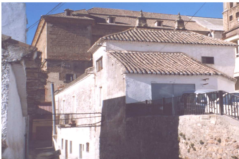
Restos del edificio del antiguo Pósito de Iznalloz, con la Iglesia al fondo.
