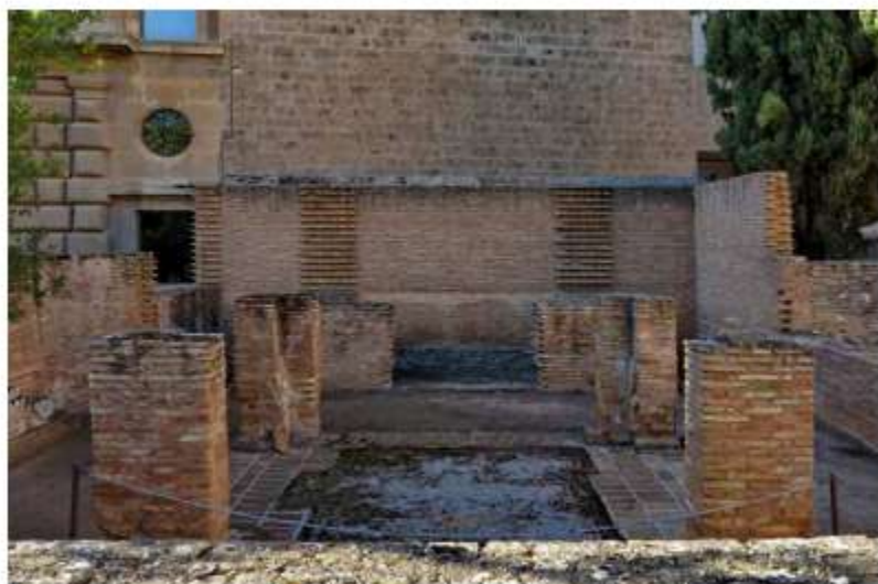
Fig.- I.28. Arranque de pilastras en esquina de qubba del cementerio de la Rawda.
