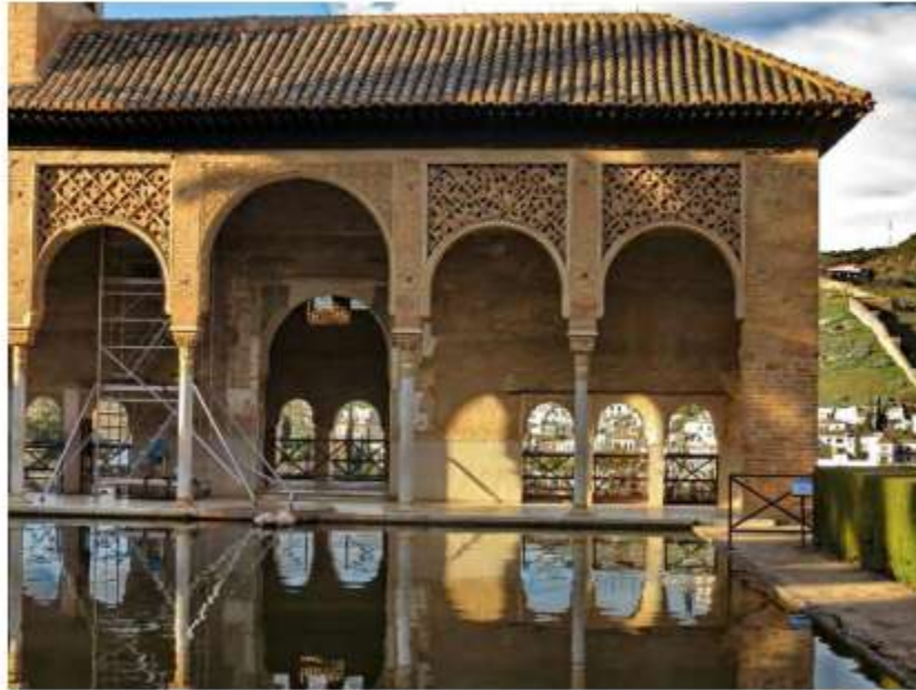
Fig.- I.32. Pórtico del palacio del Partal. celosía interior de sebka de los alfiles propuesta por Leopoldo Torres Balbás.
