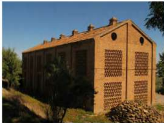
Secadero de ladrillo con celosía triangular en Otura
