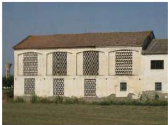
Secadero de celosía de ladrillo en Santa Fe
