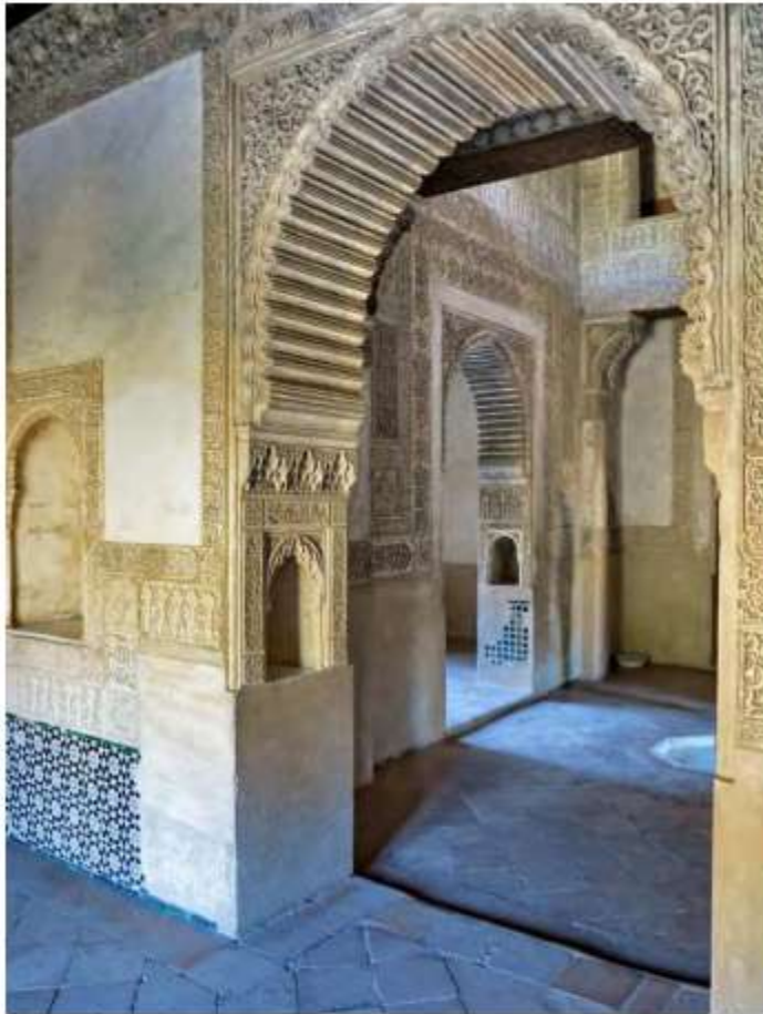
Fig.- I.112. Visión sesgada de los umbrales y de las taqa 's en el nivel inferior del interior de la torre de la Infanta.
