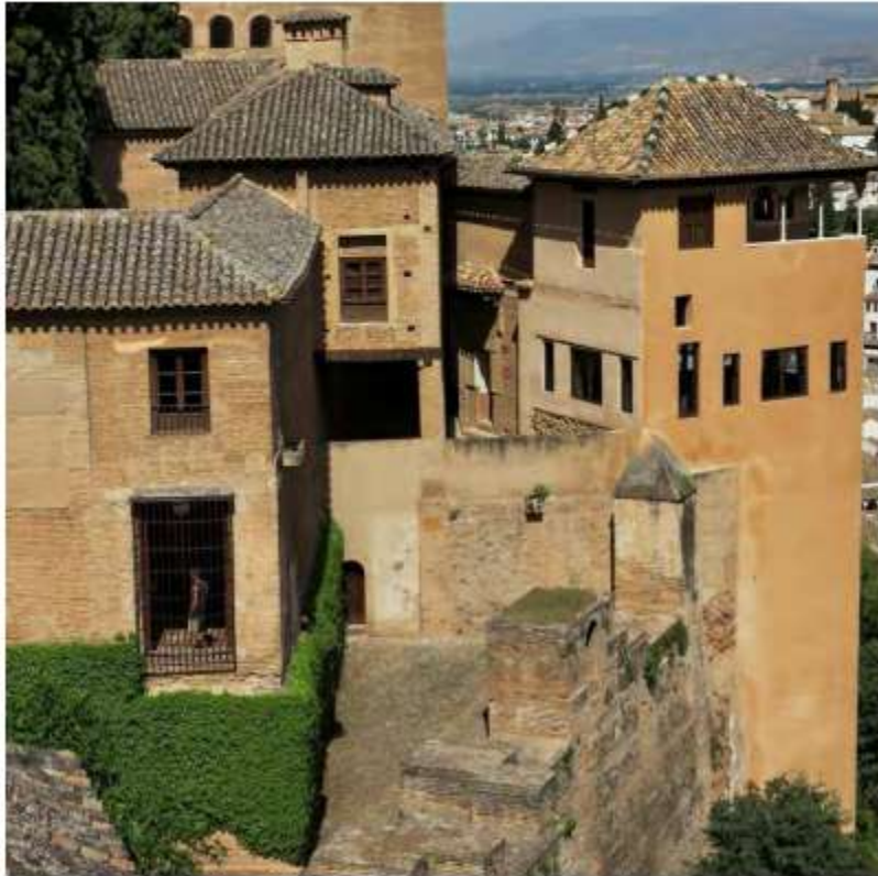
Fig.- I.3. Espacios y transiciones entre arquitecturas de distintas épocas. Peinador de la Reina y habitaciones de Carlos V desde el Parterre.
