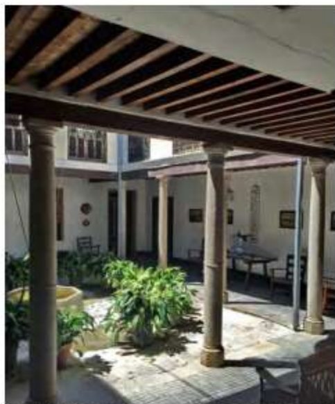
Fig.- II.14. Solería de barro primitiva existente en las zonas no reformadas.
