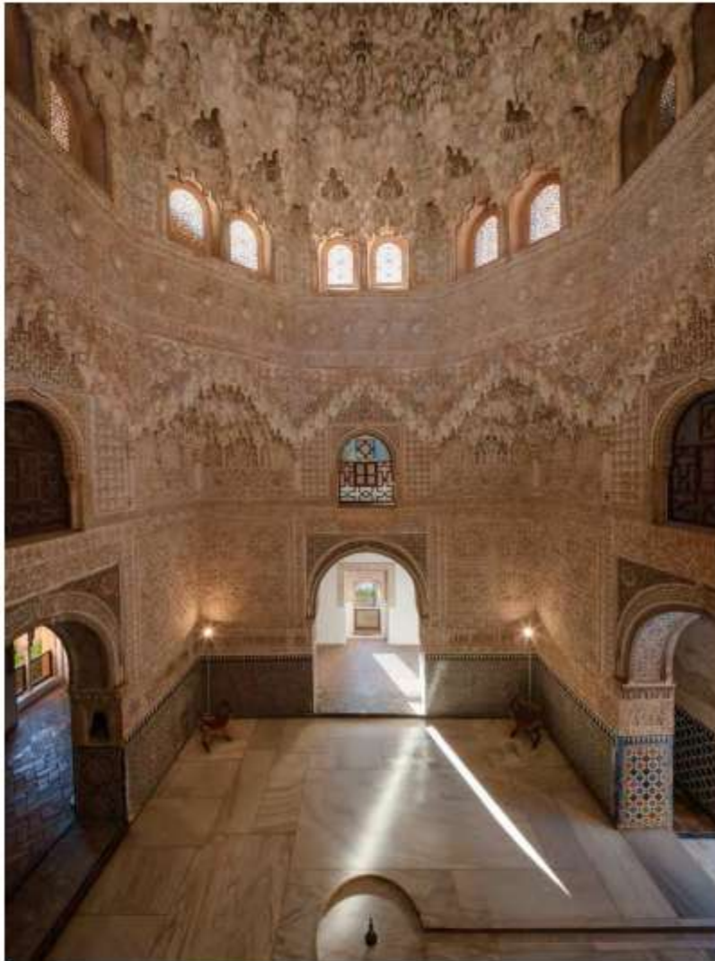
Fig.- I.84. Vista interior de la qubba de Dos Hermanas desde el nivel superior de alcobas laterales. Foto: Fernando Alda.
