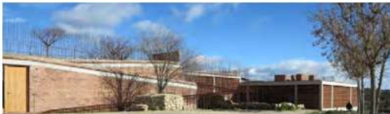
Fig.- III-5. Rampa descendente desde la cubierta del edificio.
