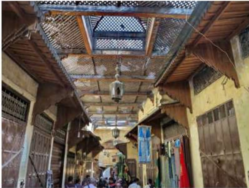
Fig.- III-68. La Medina de Fez. Techo de celosías de madera para el zoco de los artesanos.
