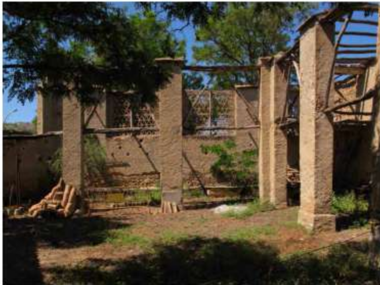
Fig.- II.85. Visto de fachada norte del secadero de tapijal.
