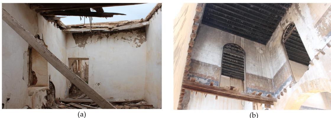
Fig. 20. (a) Dormitorio del Cortijo de Los Genoveses (Níjar) con una ventana en el cerramiento de fachada y comunicado con otro dormitorio. (b) Dormitorio del Cortijo Cayuela (Níjar) ubicado en planta alta y conectado con dos dormitorios más. Fotografías de la autora, 2020.
