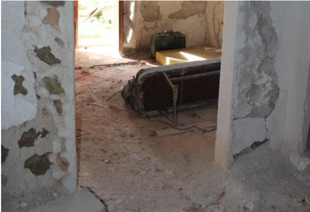
Fig. 28. Tabique del Cortijo Montano (Níjar). Cuenta con 10 cm de espesor y se materializa con la misma mampostería que los cerramientos. Fotografía de la autora, 2015.
