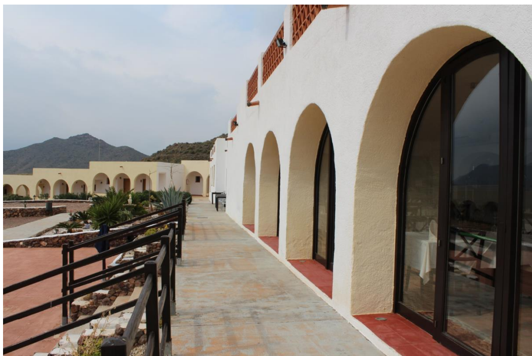
Fig 24. Soportales que conforman el porche del Cortijo El Paraíso en Níjar (Almería). A la derecha pintados de blanco se ve la construcción original y a la izquierda pintados de crema se observa la ampliación posterior ejecutada en 2004.
