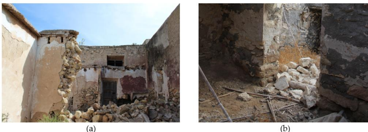
Fig. 31. (a) Tabique del Cortijo Montano (Níjar) que conserva el revestimiento blanco de cal. (b) Estancia del Cortijo Los Torres (Níjar) en la que se aprecia el suelo de tierra compactada. Fotografías de la autora, 2020.
