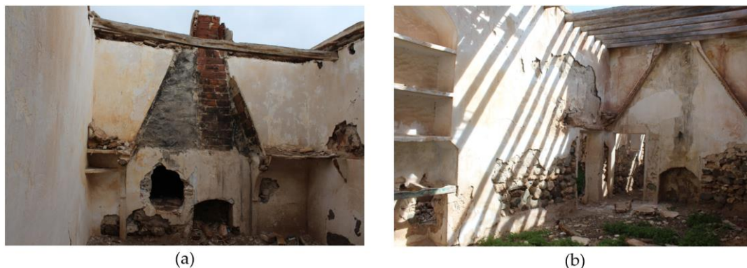
Fig. 19. (a) Chimenea de la cocina del Cortijo de Los Genoveses (Níjar), es de pequeñas dimensiones y presenta una repisa materializada con estuco. (b) Cocina del Cortijo Montano (Níjar), es de grandes dimensiones y se aprecia el acceso a distintas dependencias y una hornacina con repisas para almacenaje. Fotografías de la autora, 2015.
