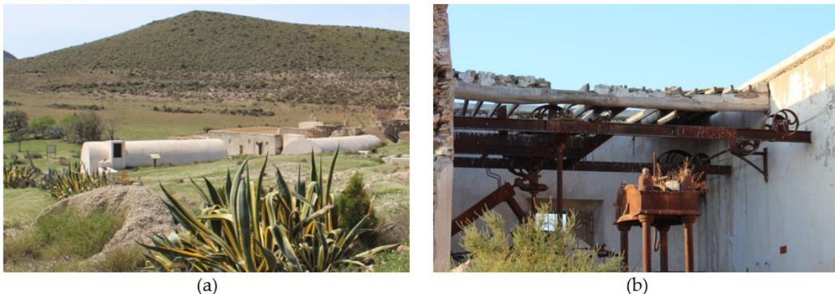
Fig. 23. (a) Dos aljibes del Cortijo Montano (Níjar) rehabilitados en 2009. (b) Almazara del Cortijo La Máquina (Níjar), ubicada en un volumen anexo tras el volumen principal del cortijo. Fotografía de la autora, 2020.
