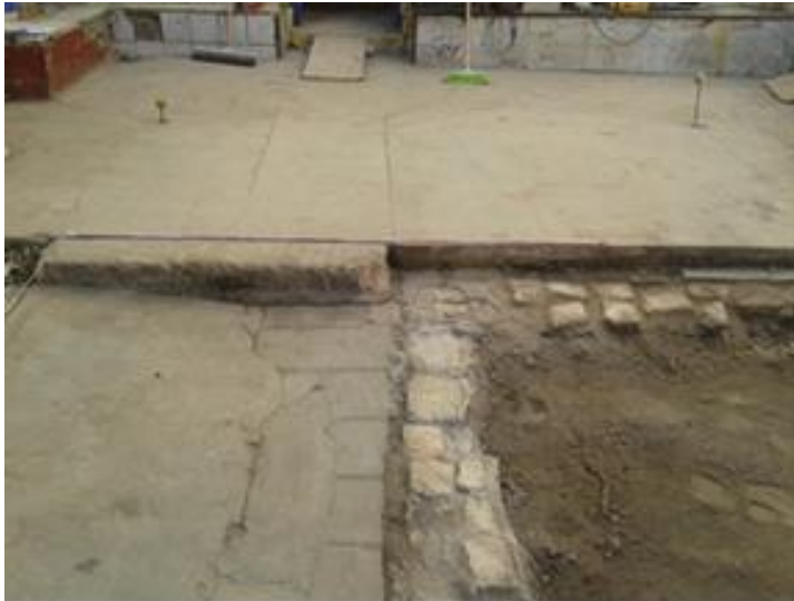
Lam. 10.- Vista general del sector 4, al inicio de la intervención.
