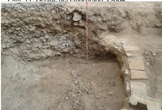
Lam. 12. Vista general de la atarjea E-008 y el registro E-009.
