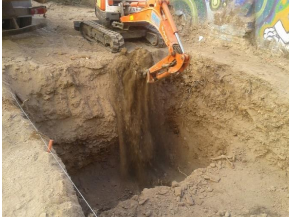
Lam. 5. Rebaje del subsector 2, e inicio de la ampliación y unión de los sectores 2 y 3
