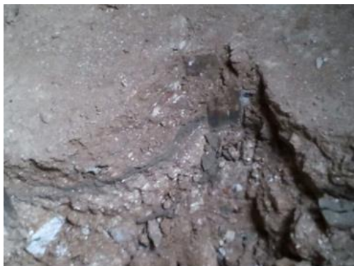
Lam. 19. Detalle de la tongada de tierra apisonada de mortero de cemento y tierra.
