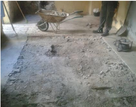
Lam. 18. Vista del sector 6, al inicio de la intervención.
