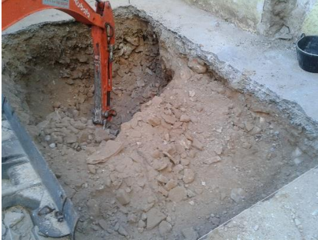
Lam. 1. Vista de las labores de rebaje del sector 1, eliminando rellenos
