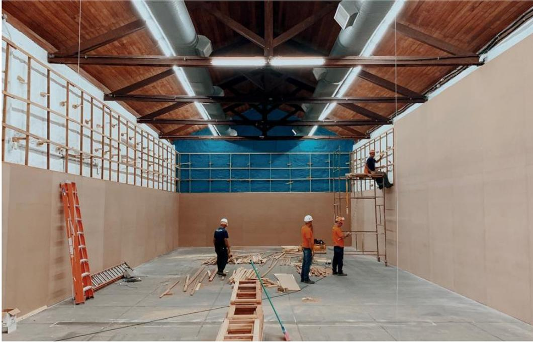
Fig. 204 – Proceso de instalación de las paredes de madera
