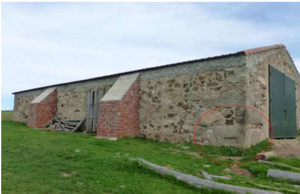
Fig. 17: Verraco reutilizado para construir un edificio (Tornadizos de Ávila, Ávila) (Imagen extraída de Verracos.es: n° 188, y modificada por el autor).
