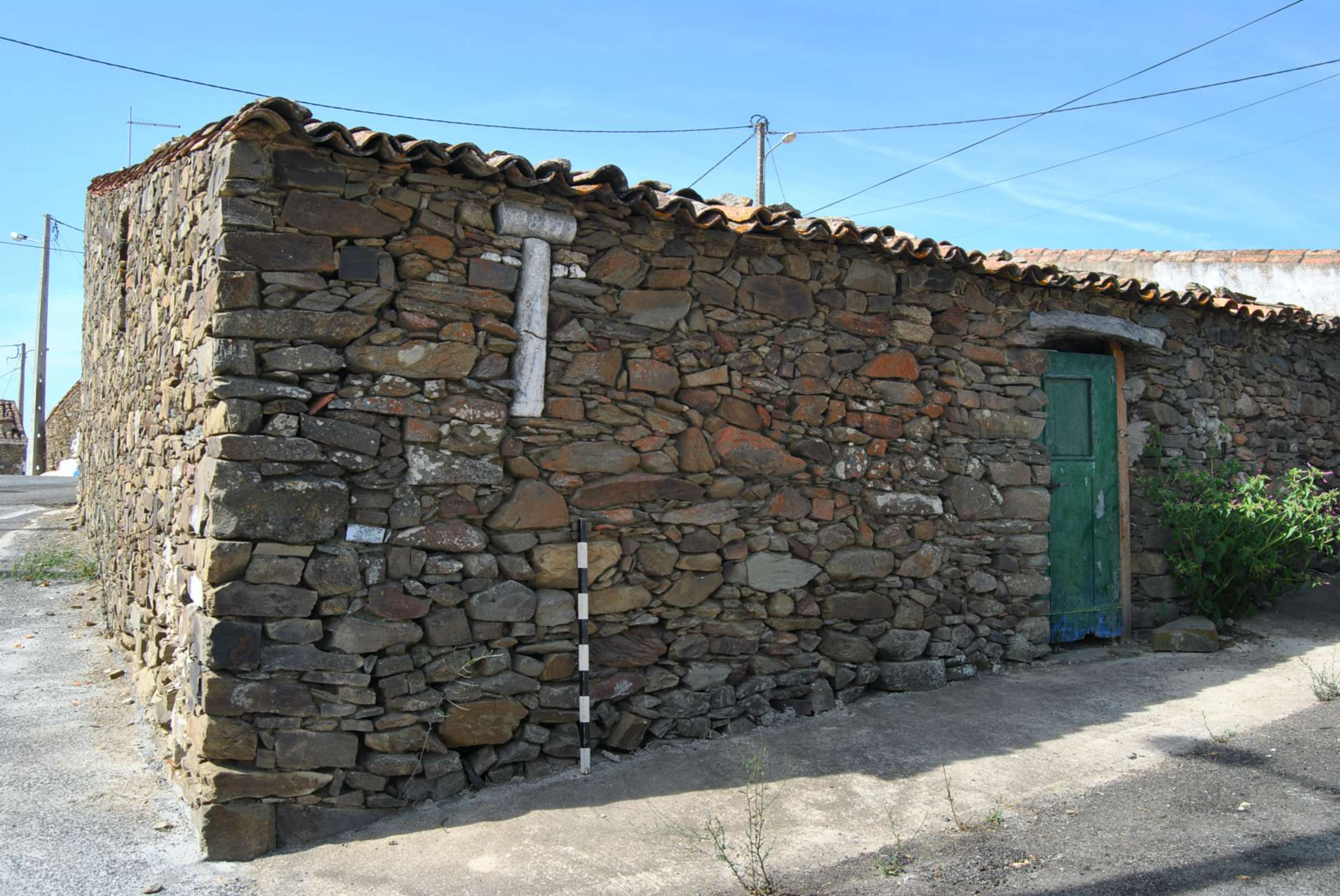
Fig. 7 - Dois fustes de colunas, reutilizadas numa parede em alvenaria de pedra, na Aldeia de Mesquita. Pode ler-se na coluna horizontal a data de 1831, possivelmente a data de colocação neste sítio.
