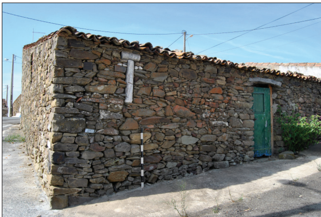
FIG. 4 – Dois fustes de colunas reutilizados numa parede em alvenaria de pedra, na Aldeia de Mesquita. Pode ler-se na coluna horizontal a data de 1831, possivelmente a data de colocação neste sítio.
