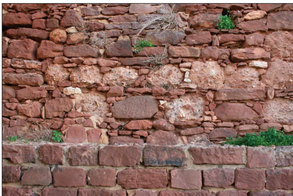
FIG. 6 – Troço de muralha da medina de Silves reconstruído com alvenaria de pedra e blocos de taipa provenientes de derrubes.
