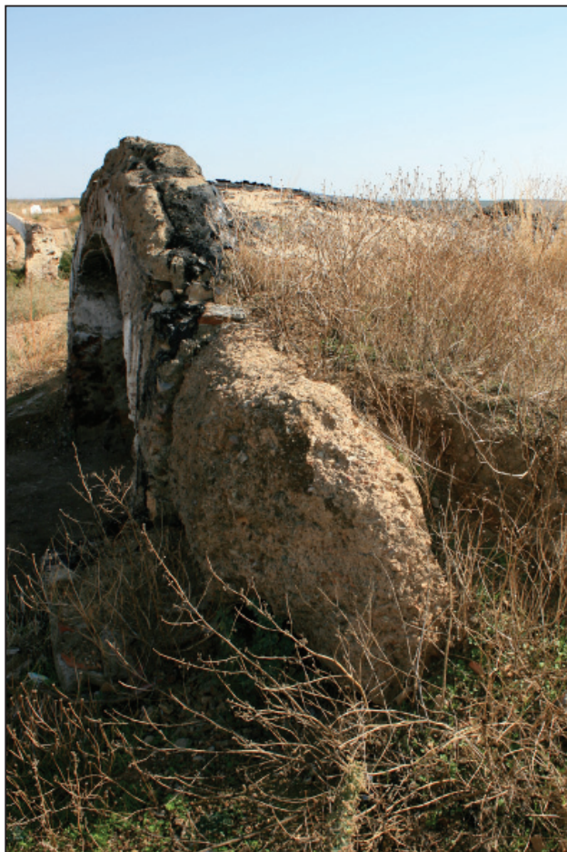
FIG. 7 – Canhoeira da fortaleza de Campo Maior antes da intervenção de reconstrução.
