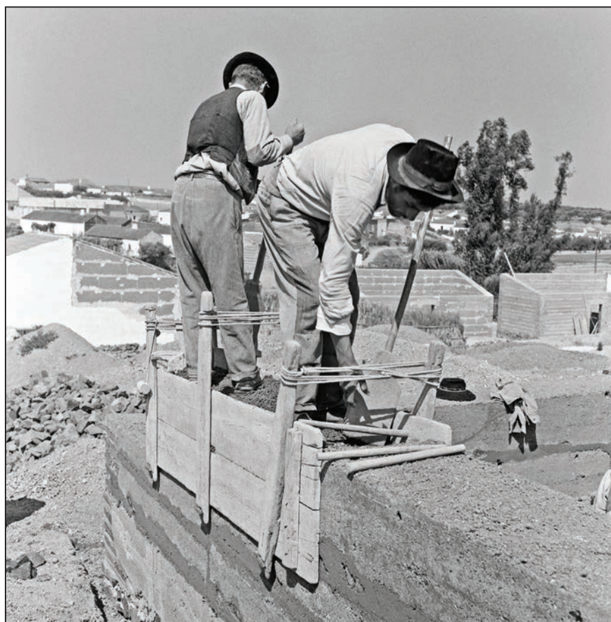
FIG. 2 – Construção de taipa, Alfundão, Ferreira do Alentejo. Inquérito à Arquitectura Regional Portuguesa . © Ordem dos Arquitectos, PT-OA-IARP-BJA-FAL01-010.
