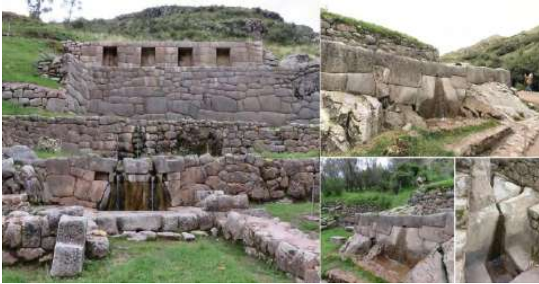
Figura 11. Fuentes de agua prehispánica en la cultura Inca. Tambomachay (1, 2 y 3) y Puka Pukara (4). Fotografía: M.I. Mayorga, 2017.
