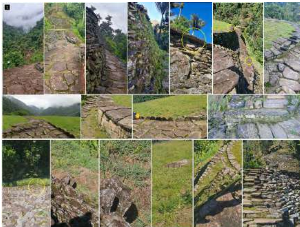
Figura 29. Aspectos constructivos y manejo del agua en el sector Eje Central. Fotografías: M.I. Mayorga, 2022.
