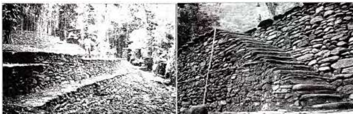
Figura 64. Muros de contención de terrazas, caminos y escaleras.
