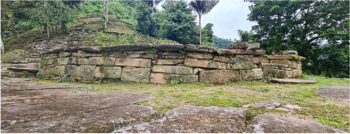
Figura 36. Anillo 35 factura del muro del anillo con sillares de piedra. Fotografías: M.I. Mayorga, 2022.
