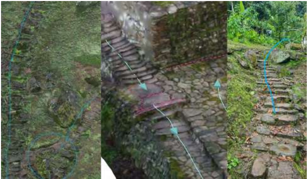
Figura 179. Elementos de control del agua. Elaboración propia, 2023.
