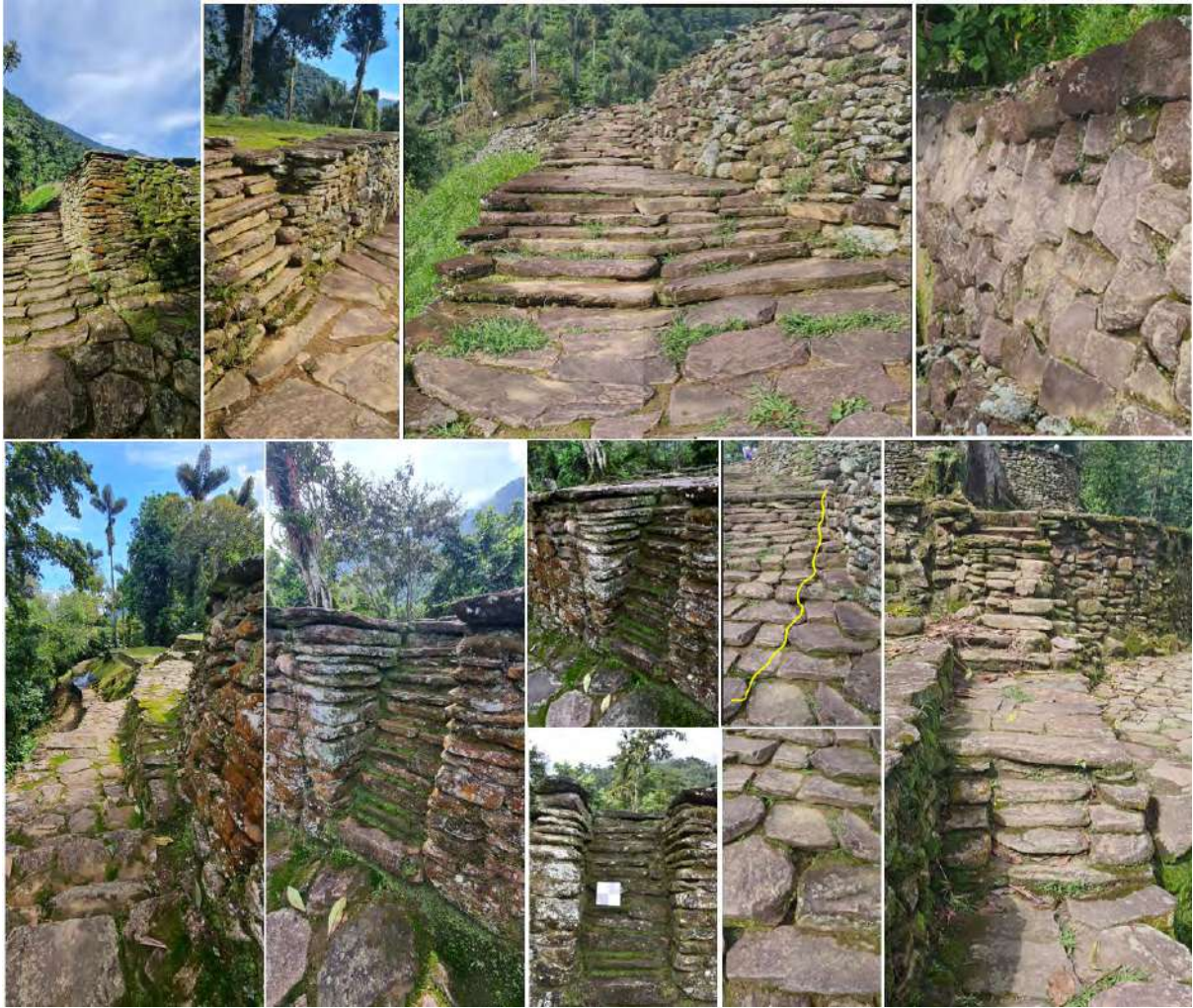
Figura 35. Escaleras y muros en la zona Eje central. Se muestran muros realizados con metates y escaleras con tramos de descanso. Fotografías: M.I. Mayorga, 2022.
