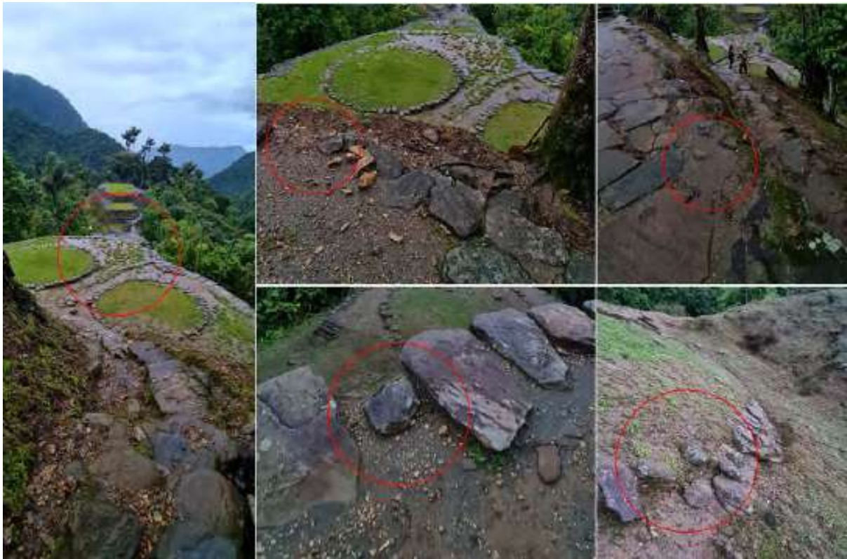
Figura 48, Sector Eje Central, empozamientos, movimiento o pérdida de lajas gotera, detectados el primer día de trabajo de campo. Fotografías: M.I. Mayorga, 2022..
