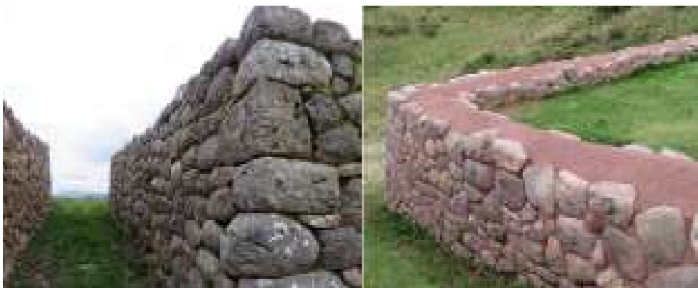
Figura 13. Muros prehispánicos rellenos con tierra en Puka Pukara. Fotografía: M.I. Mayorga, 2017.
