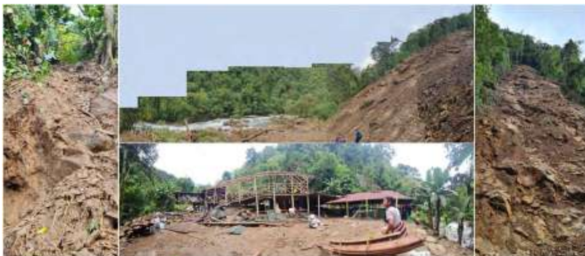
Figura 15. Zonas de deslizamiento, se muestran tres zonas donde se interrumpió el camino y desmonte del sitio el paraíso, parte del cual fue destruido. Fotografías: M.I. Mayorga, 2022.
