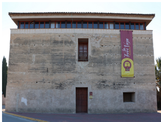
Fig. 1.11 Torre del Obispo (Alguazas), edificación defensiva transformada en mirador y museo.
