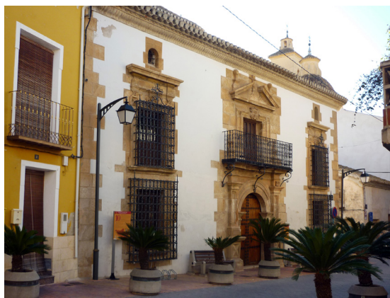
Fig. 1.9 Palacio Llamas, en Ricote, edificación residencial empleada actualmente como dotación cultural.
