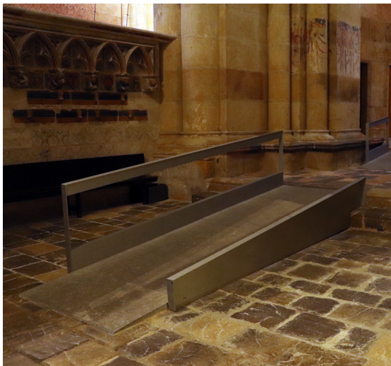
Fig. 2.11 Suprimir la característica: una serie de rampas en la Catedral de Tarragona permiten la supresión de desniveles, característica que impide la accesibilidad para personas usuarias de silla de ruedas.
