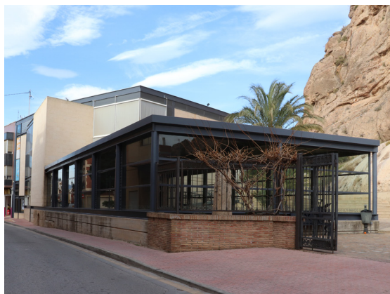
Fig. 4.8 Baños termales de Alhama de Murcia, edificio catalogado como BIC y clasificado como museo, además de como arquitectura civil, según la CARM.
