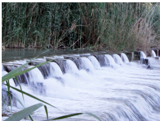
Fig. 4.10 Azud de la Contraparada, construcción sobre el río Segura en Murcia, catalogada como BIC y calificada como obra de ingeniería según la CARM.
