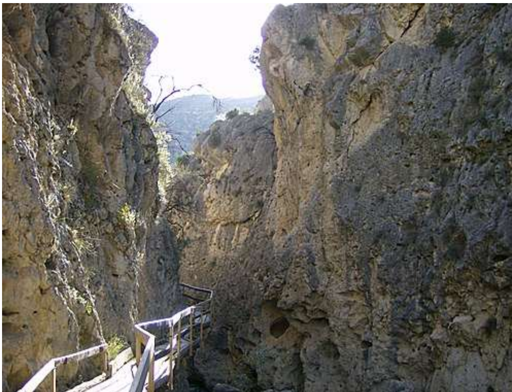
Figura 9: Pasarela en la Cerrada del Río Castril.
