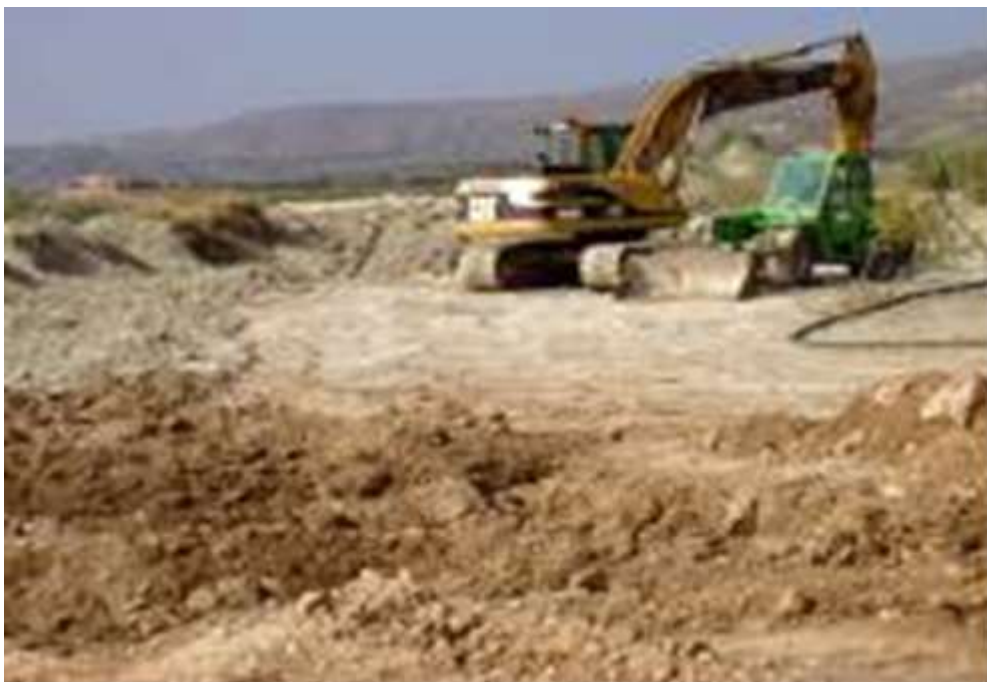
Figura N°??: ACTUACIONES DE LAS MAQUINARIAS SOBRE LOS TERRENOS.
