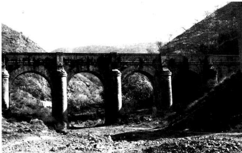
Lámina 9. Acueducto de San Telmo, puente sobre el arroyo Humaina de la provincia de Málaga
