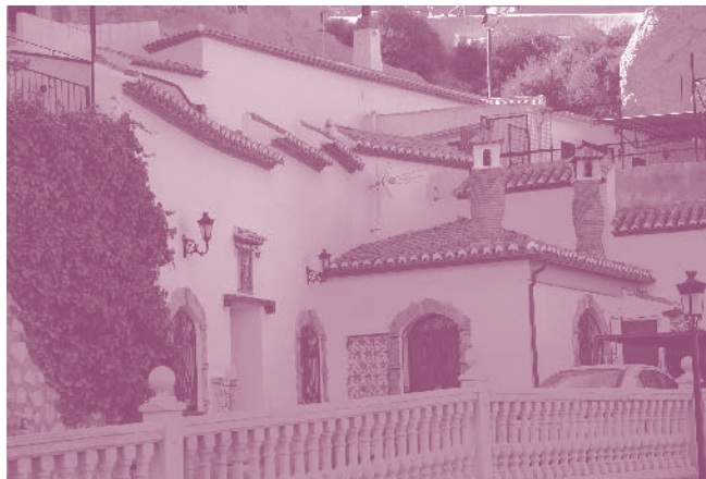
FIG. 9. Fachada de una cueva rehabilitada con nuevas propuestas en elementos como las chimeneas. El Marchal
