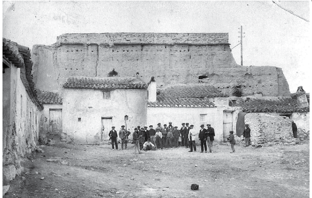
Restos de la alcazaba de Baza, actualmente desaparecidos, que desde el final del s. IX, fueron levantados y dieron origen a “Madīnat Baṣṭa”, la actual Baza.
