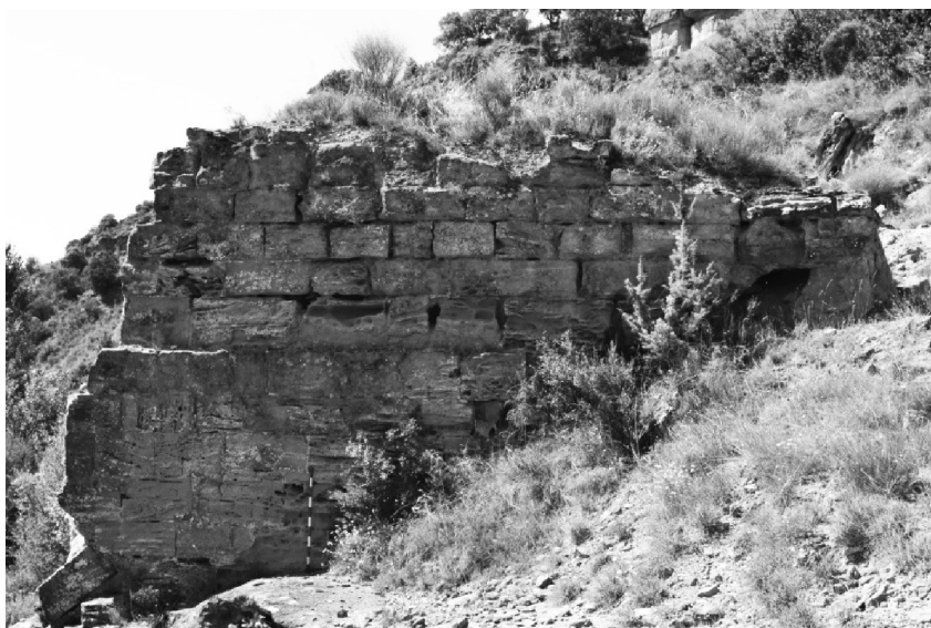
Fig.9. Vista norte del estribo oeste del puente
