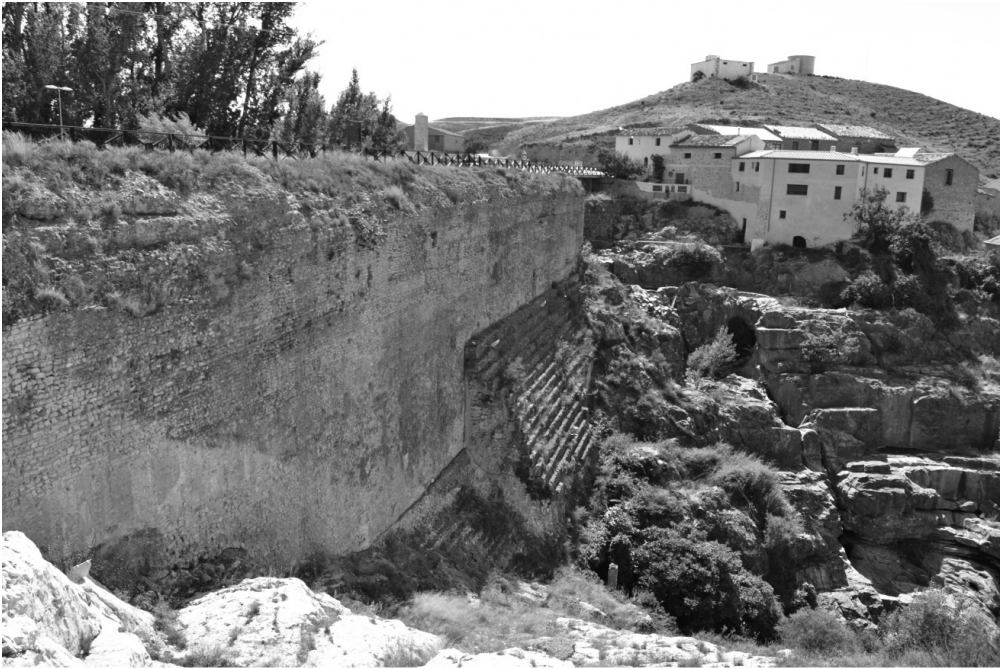
Fig. 17. La presa de Almonacid de la Cuba
