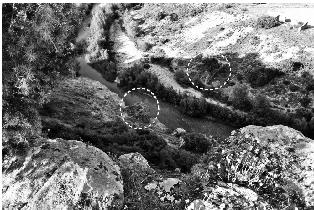
Fig.10. Vista superior de los estribos este y oeste del puente
