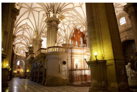
Figura 10. Bóvedas de la Catedral de Guadix
