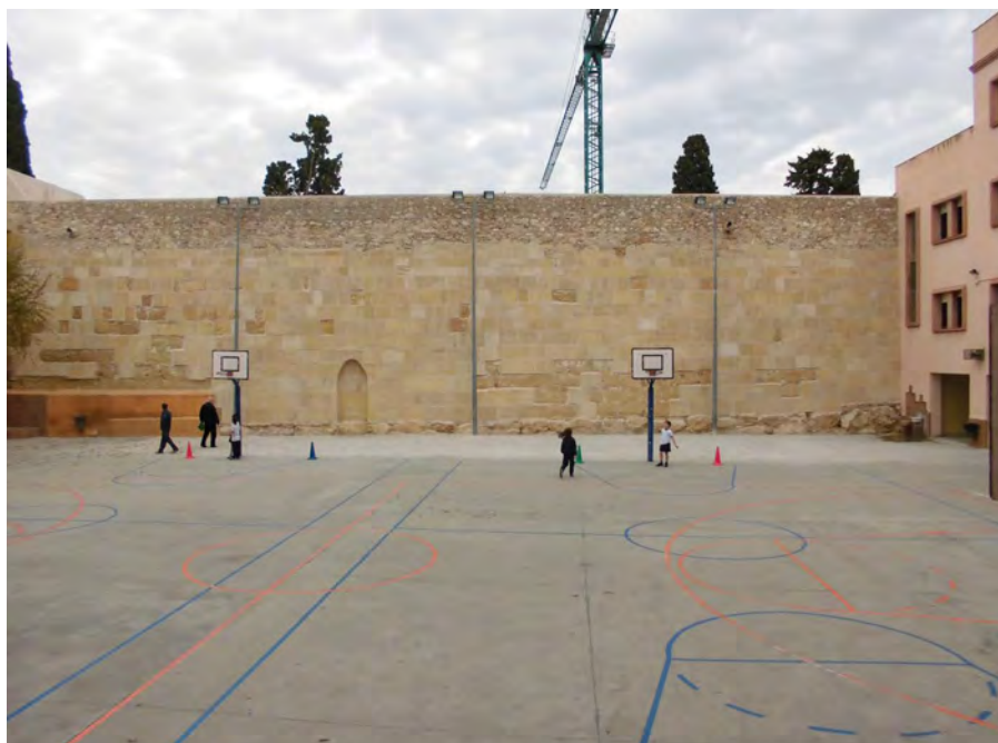
Tramo de muralla en el patio del colegio Lestonnac. Su restauración ha permitido la recuperación de este espacio para los alumnos | foto J. Menchón, Ayuntamiento de Tarragona
