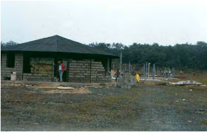
Construcción avanzada de Campamento Turisor en Sierra de Lema
