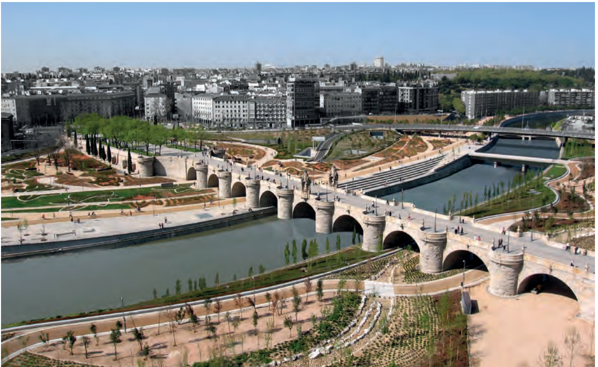
Jardines del Puente de Toledo pk 3,50-4,10 (norte-sur)
