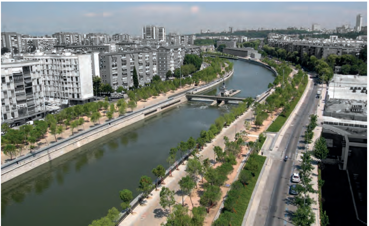
Salón de Pinos pk 2,90-3,80 (norte-sur)
