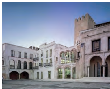
Edificio para una Concejalía [GAL0458] Badajoz, España Begoña Galeano Díaz y Carmen González Peramato
