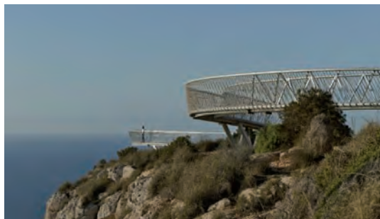
Carril Bici Santa Pola - Gran Alacant [DEL0113] Santa Pola (Alicante), España RAS arquitectos (Prócoro del Real Baeza y Antoni Baile Jiménez)
