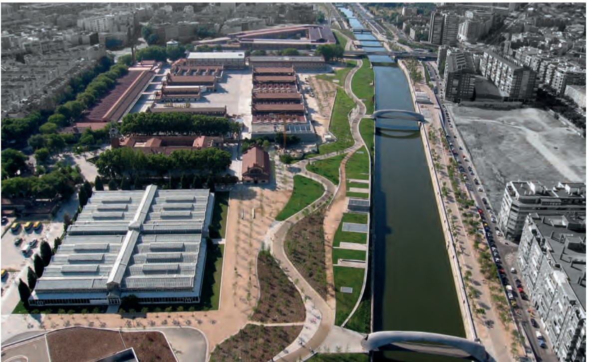
Matadero pk 6,10-6,80 (norte-sur)
