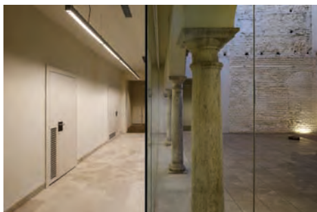
Rehabilitación antiguo colegio Ignacio Halcón [GAR0116] Lebrija, Sevilla García Torrente Arquitectos SLP
