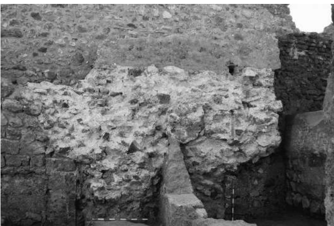
Fig. 13. Onda. Vista de la cara interna de la antigua puerta monumental, de la que dos jambas de sillería. El muro dispuesto perpendicular a la muralla, obra de tapial de tierra sobre zócalo de mampostería, documenta su clausura. En la parte central de la foto se aprecia una obra irregular a base de mortero de cal y piedra que pertenece al muro de contención que se construyó cuando se produjo el colapso de la puerta
