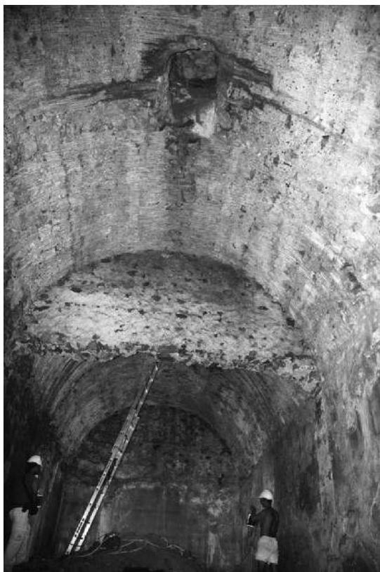
Fig. 28. Onda. Interior del aljibe de la plataforma inferior del palacio
