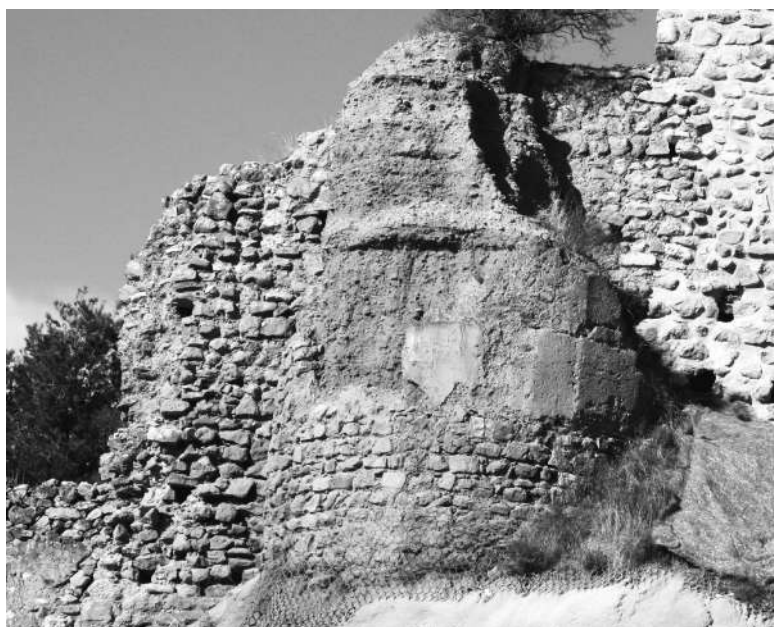
Fig. 9. Onda. Frente oriental de la alcazaba. Detalle del torreón meridional. Obsérvese la técnica constructiva consistente en un zócalo de mampostería sobre el que se alza la obra de tapial calicastro
