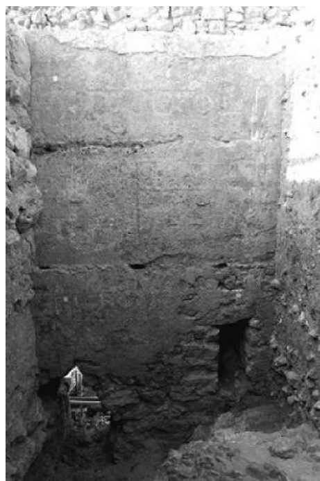
Fig. 16. Onda. Edificio administrativo. Frente meridional visto desde dentro. Esta estructura se alza en la parte en la que la base rocosa se encontraba más baja, lo que explica que funcionara como muro de contención. Obsérvese su basamento de mampostería sobre el que se levanta la obra de tapial en la que se distinguen tres cajas
