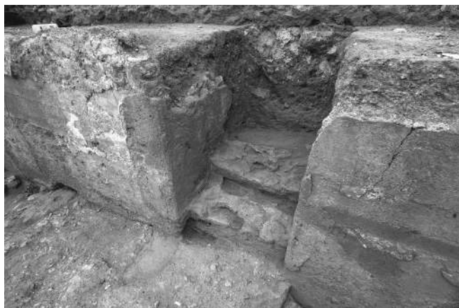
Fig. 25. Onda. Área de acceso al palacio situada en la crujía oriental. La escalera daba acceso al hipotético salón de recepciones situado en la planta alta de la crujía oriental. Es una reforma que rompe el muro de tapial original y prueba de ello es que sus jambas no fueron reforzadas con obra de sillería o de mampostería
