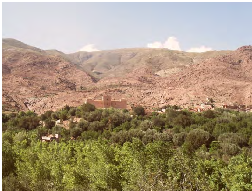
Fig. 5. Vista de la mezquita de Tinmal desde el S. Obsérvese su aspecto de fortaleza (Sarr & Mattei 2019)
