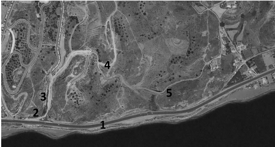
Figura 10. Ortofoto actual (vuelo 2011) de la zona del Tercer Cantal, con los elementos más representativos indicados. 1-Carretera N-340; 2-Alcantarilla; 3-Ascenso en desmonte; 4-Puerto; 5-Puente del Arroyo del Jaral.
