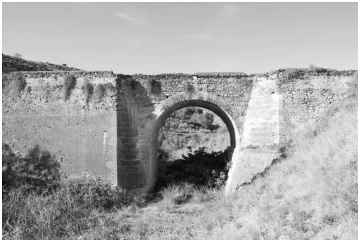
Figura 13. Puente del Arroyo del Jaral, en el descenso del Tercer Cantal
