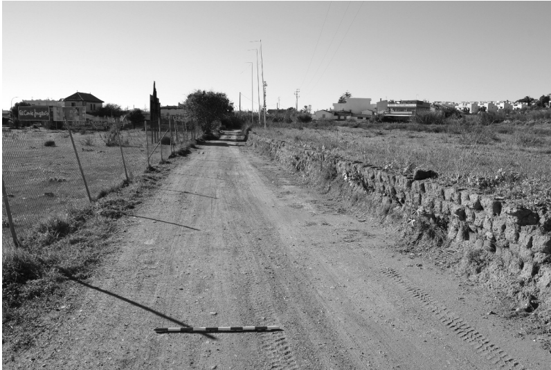
Figura 9. Tramo original del Camino de Vélez en las inmediaciones del arroyo Santillán. Torre de Benagalbón (Málaga)
