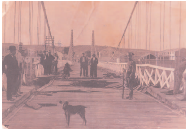
Fig. 6.:El puente tras el accidente de 1930. Cortesía de D. Sebastián Barahona Vallecillo.
