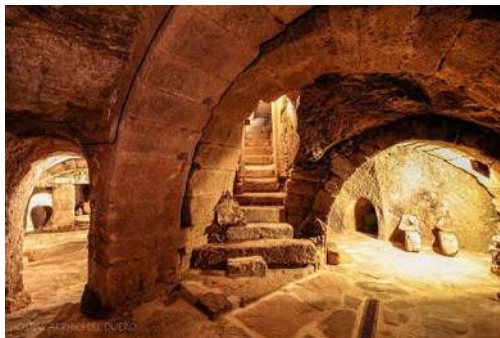
Img. 12. Bodega de vivienda conocida como Sinagoga en Famoselle, España 330 .
