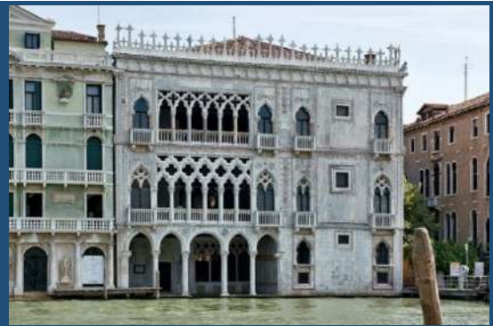
Img. 104. Fachada de Cad d'Oro 673 .
