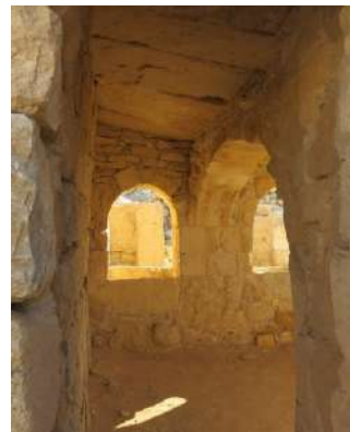
Fotografía 3. Detalle del interior de la casa “estable house” en Shivta (Israel).
