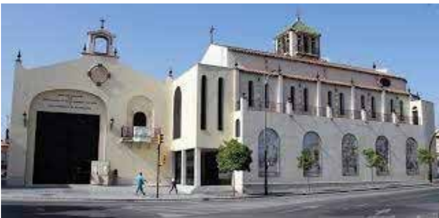
IMAGEN 35: Complejo Arquitectónico de la Archicofradía del Paso y Esperanza.
