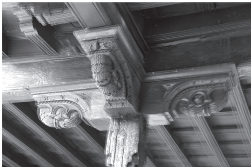
Fig. 1: Anaglifo de un pie derecho perteneciente a la estructura de la Casa del Chapiz (Fuente: imagen cedida por José Juan Castro Torres)* Véase N. del A. al final
