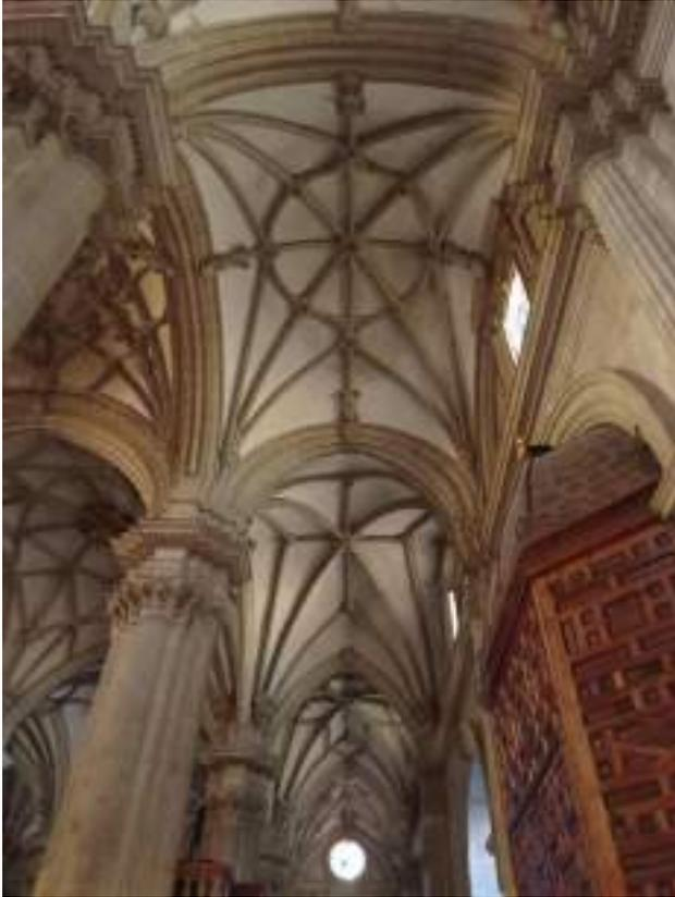
Fig. 9. Vista interior de la catedral de Guadix, donde se aprecia el cambio de bóvedas y arcos tras la unión de la fábrica vieja con la nueva.
